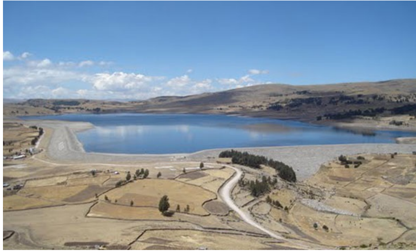
Figura 2.2: Presa cuchoquesera Ayacucho-Peru.
