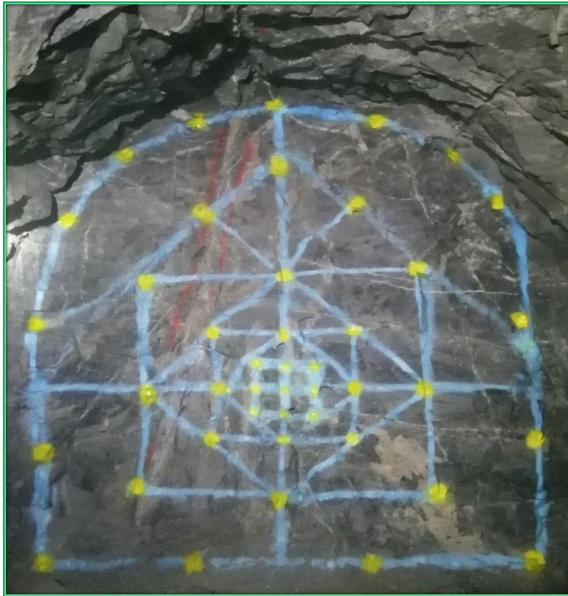
cargio del frente con faneles y pentacord em bp 685
