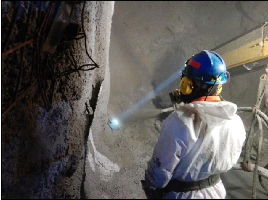
Lanzado de concreto con robot Putzmeister
