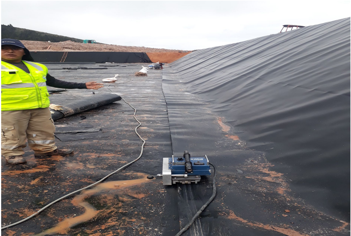
Fotografía N° 09: se observa la unión de costuras con la cuña
