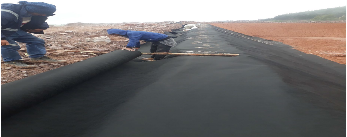
Fotografía N° 01: se observa el tendido de la geotextil
