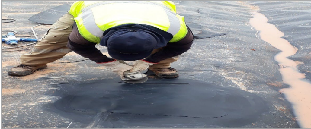
Amolado de la lámina de geomembrana de 1.5 mm
