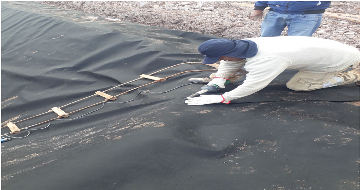
Fotografía N° 02: se observa el empalme de geotextil con el leister
