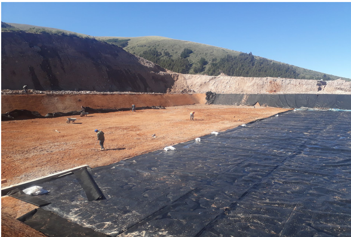
Fotografía N° 06: se observa el tendido de geomembrana en el margen derecho
