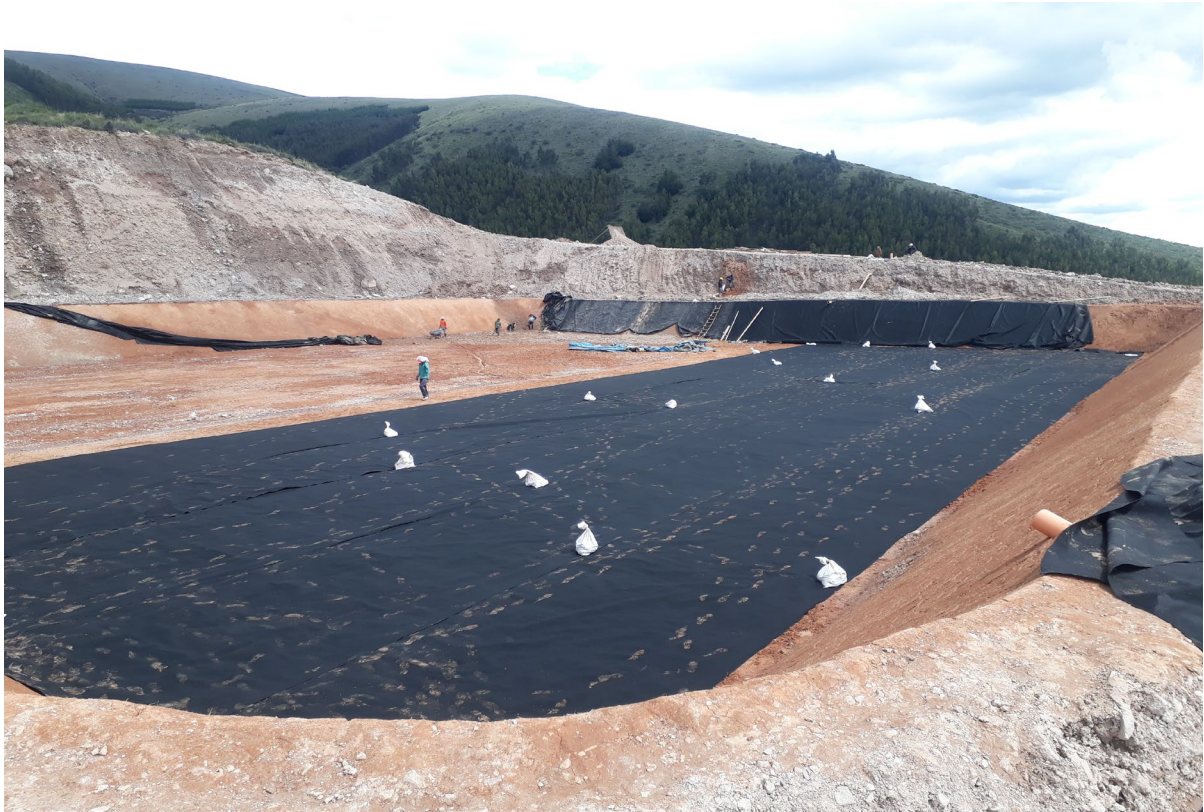
Fotografía N° 03: se observa El tendido de geotextil en la base del reservorio
