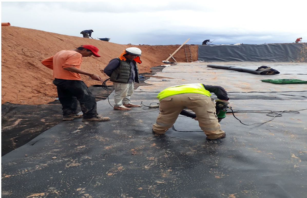
Fotografía N° 12: se observa el sellado con la extrusora
