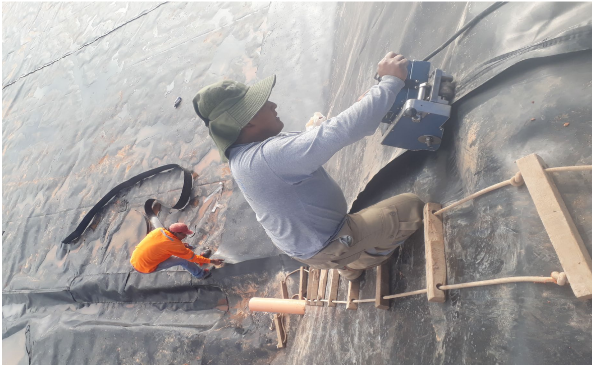
Fotografía N° 07: se observa la unión de paneles con la cuña
