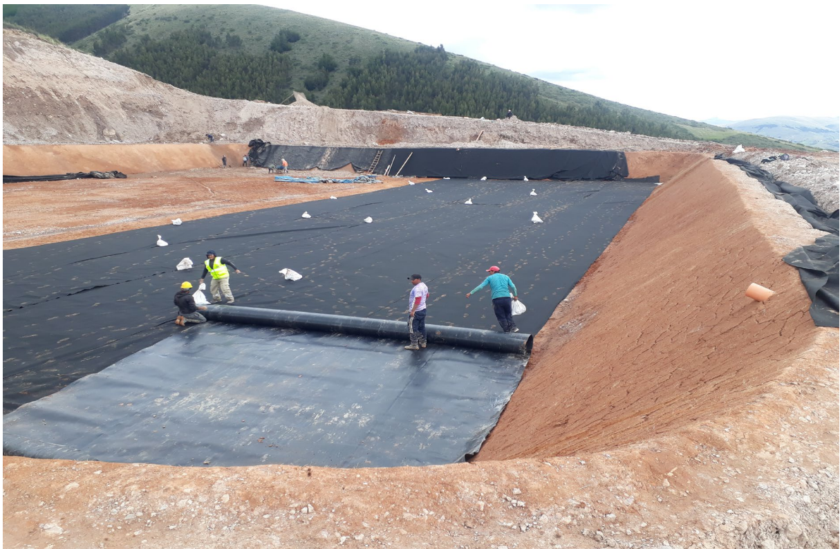
Fotografía N° 04: se observa el tendido de geomembrana en la base del reservorio
