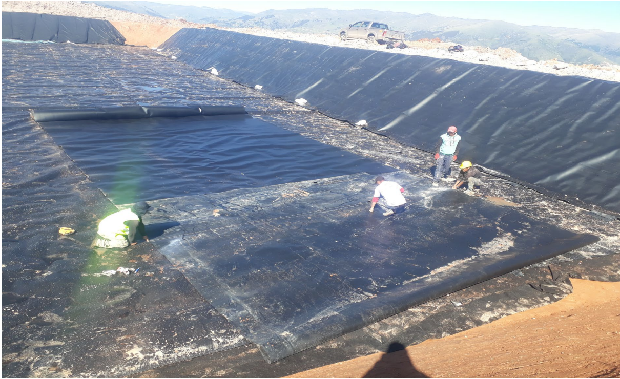
Fotografía N° 05: se observa el tendido de geomembrana en todo el reservorio
