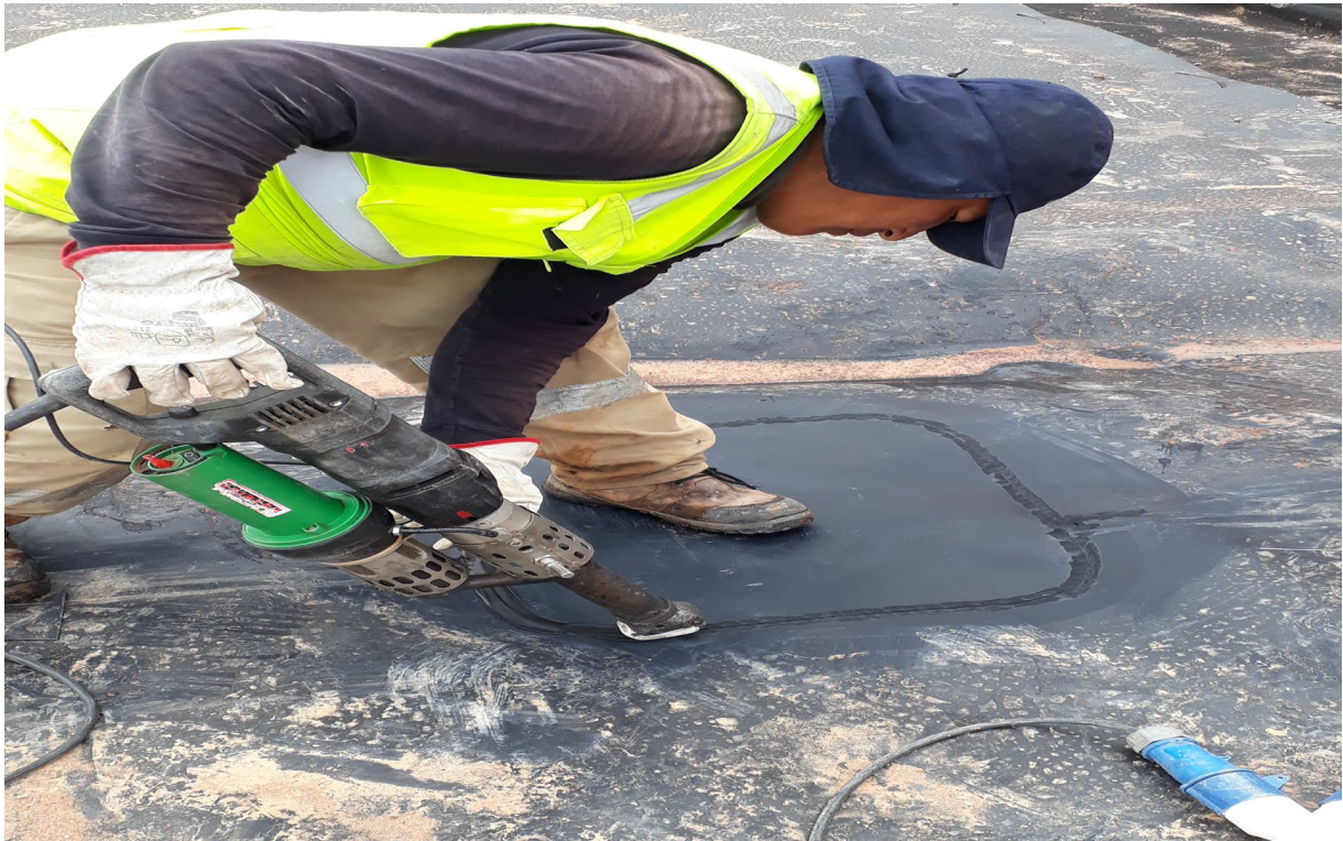
Fotografía N° 11: se observa el sellado con la extrusora
