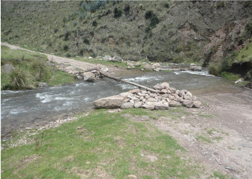
Fotografía 7: Punto de aforo de la cuenca Puytooc, donde se evidencia la carencia una estructura hidráulica.
