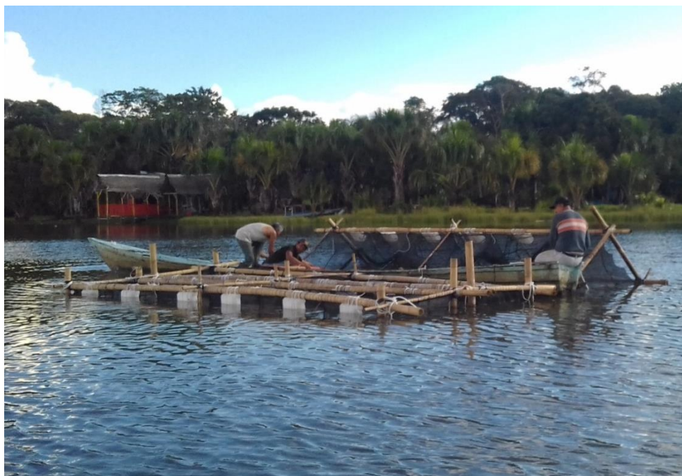
Colaboradores de la asociación Puka Shungo instalando y anclando las jaulas flotantes en la laguna de Los Milagros.
