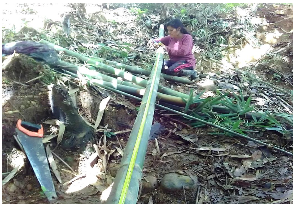
23 b. Midiendo los palos de bambú Dendrocalamus asper , para el armado de las jaulas flotantes.
