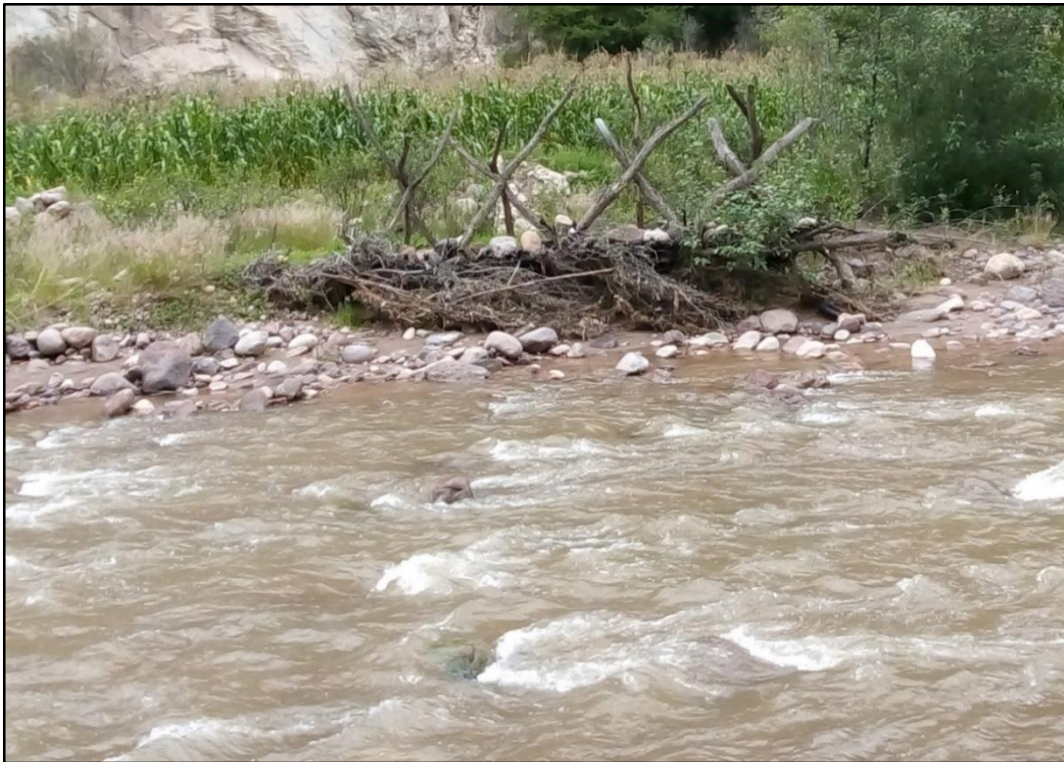
Fotografía 12: presencia de caballetes de protección, 26/03/2019.
