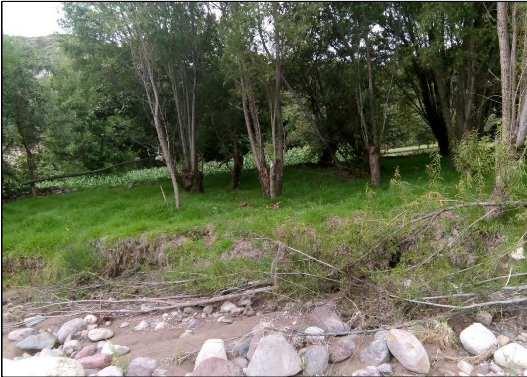
Fotografía 9: Zonas inundables por la crecida del río, 23/09/2019.
