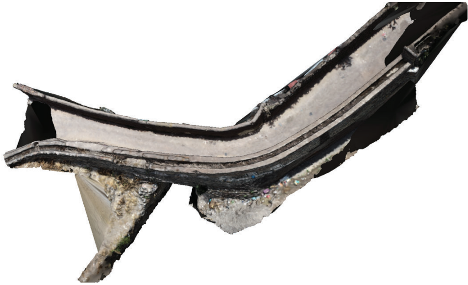
Figura 4.10: Estructura del puente Sutuy Chaca.
