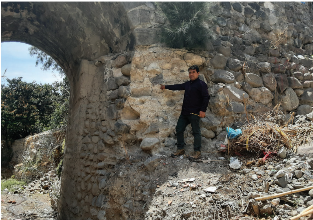
Figura 3.10: Toma de datos del puente Sutuq Chaca.
