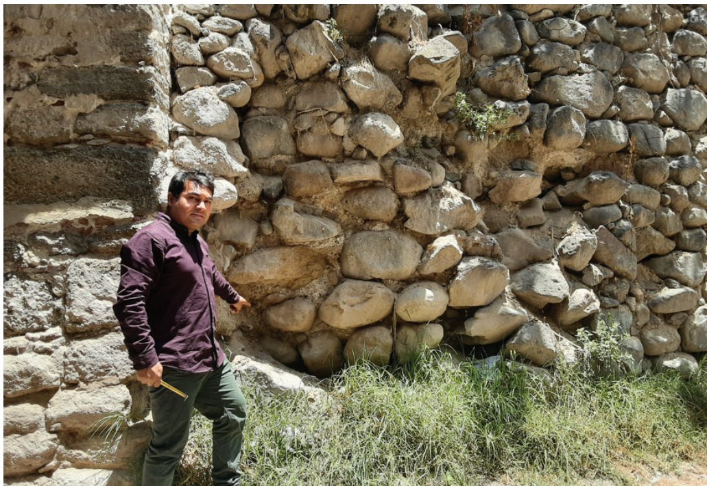
Figura 3.12: Toma de datos del puente Sutuq Chaca.
