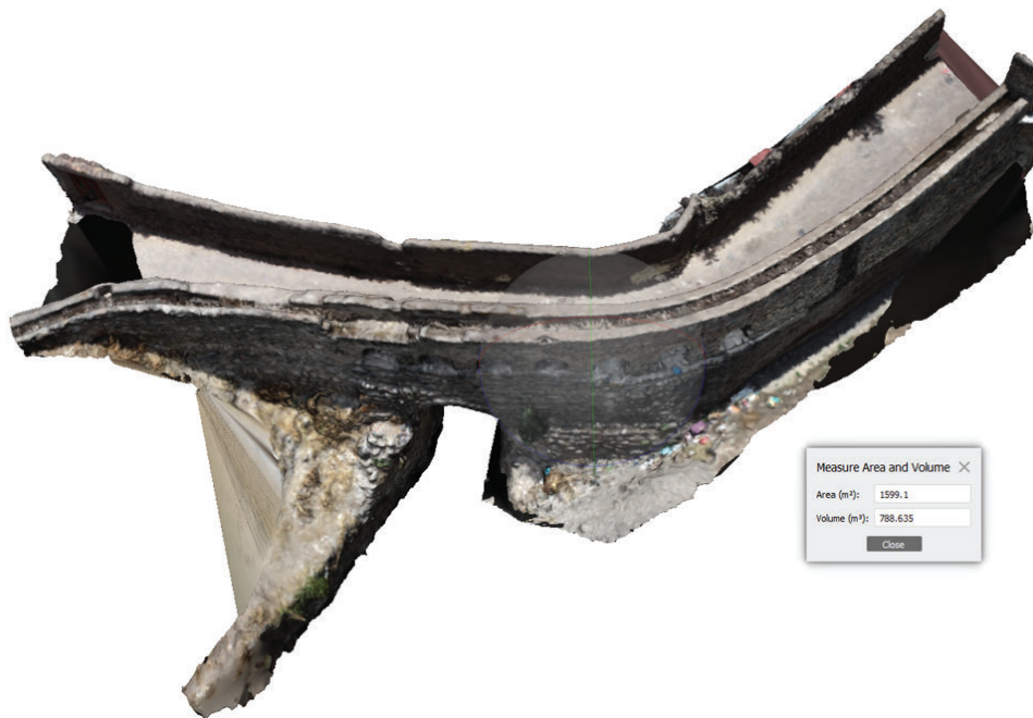
Figura 4.13: Estructura del puente Sutuy Chaca.
