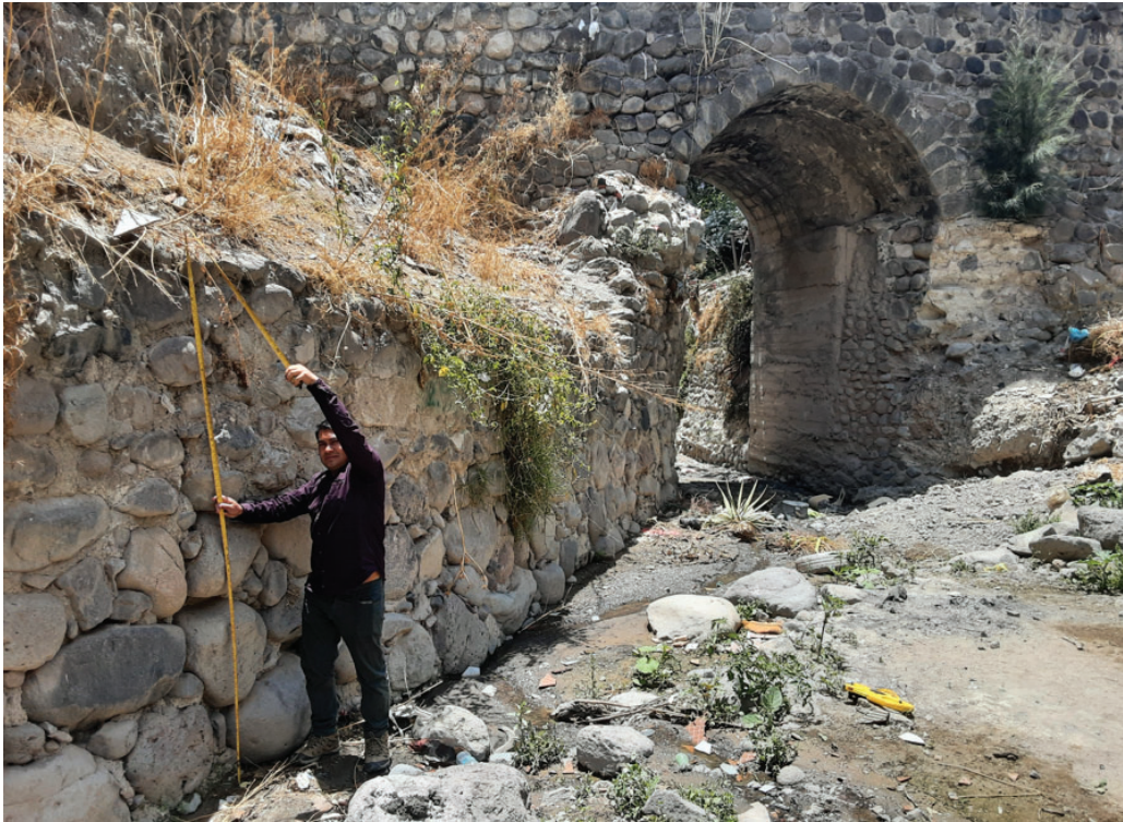
Figura 3.9: Toma de datos del puente Sutuq Chaca.
