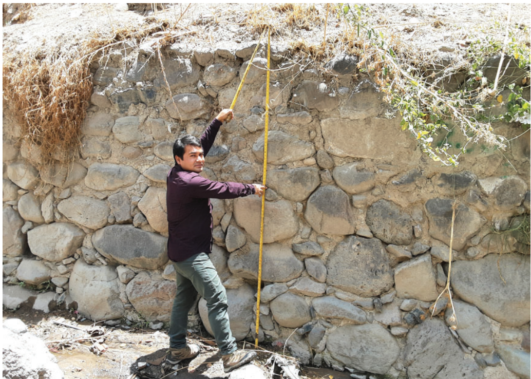
Figura 3.8: Toma de datos del puente Sutuq Chaca.
