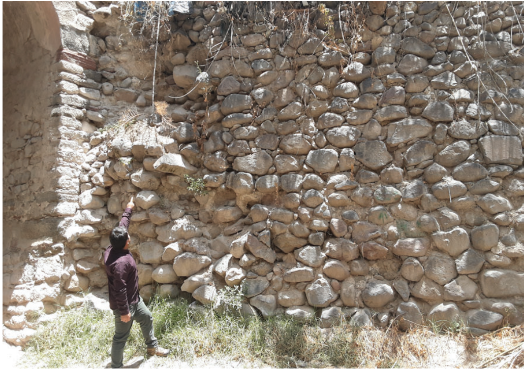
Figura 3.13: Toma de datos del puente Sutuq Chaca.
