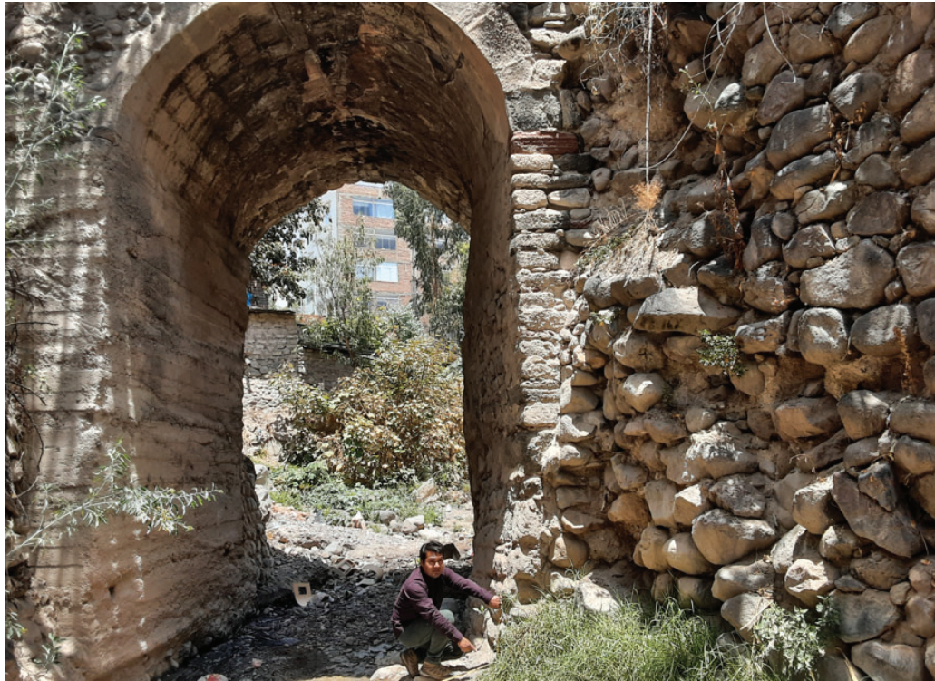
Figura 3.11: Toma de datos del puente Sutuq Chaca.
