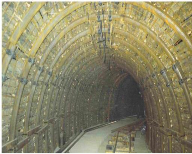
Sostenimiento con entibación metálica
