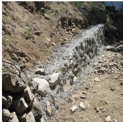
Foto 11 y 12. Construcción de muros de soporte para plataformas horizontales.
