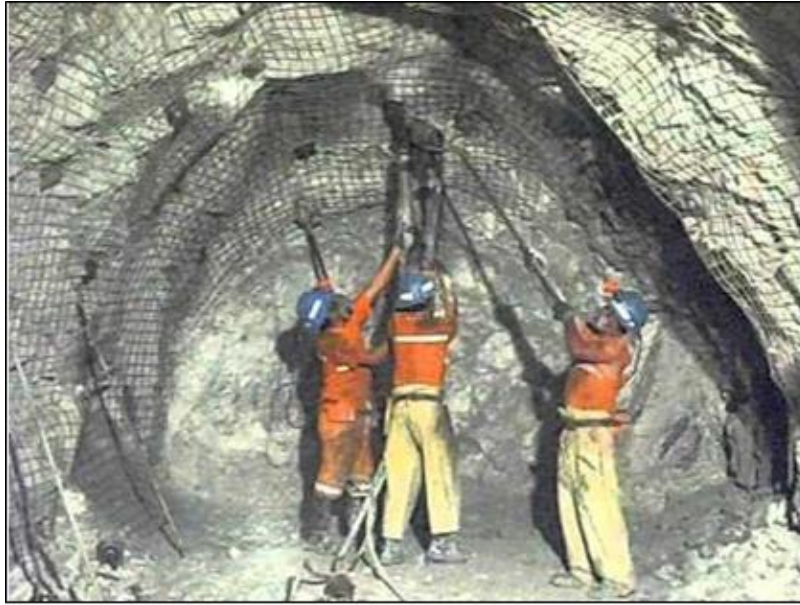
Figura 19: Colocación de Perno Split Set.
