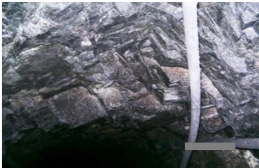
Figura 4: Sistemas de discontinuidad en labores mineras CMH.
