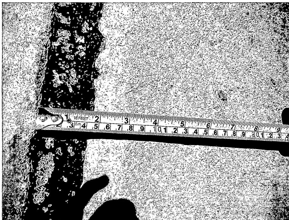
Figura F.10: Medición de Ancho de la junta
