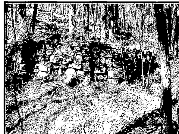
Fig. 68h Detalle del muro
