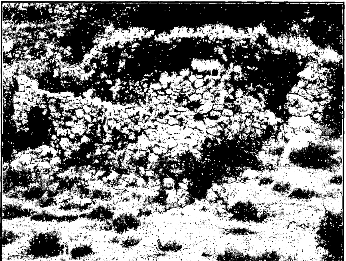
Fig. 37b estructura circular - vivienda de poblado
