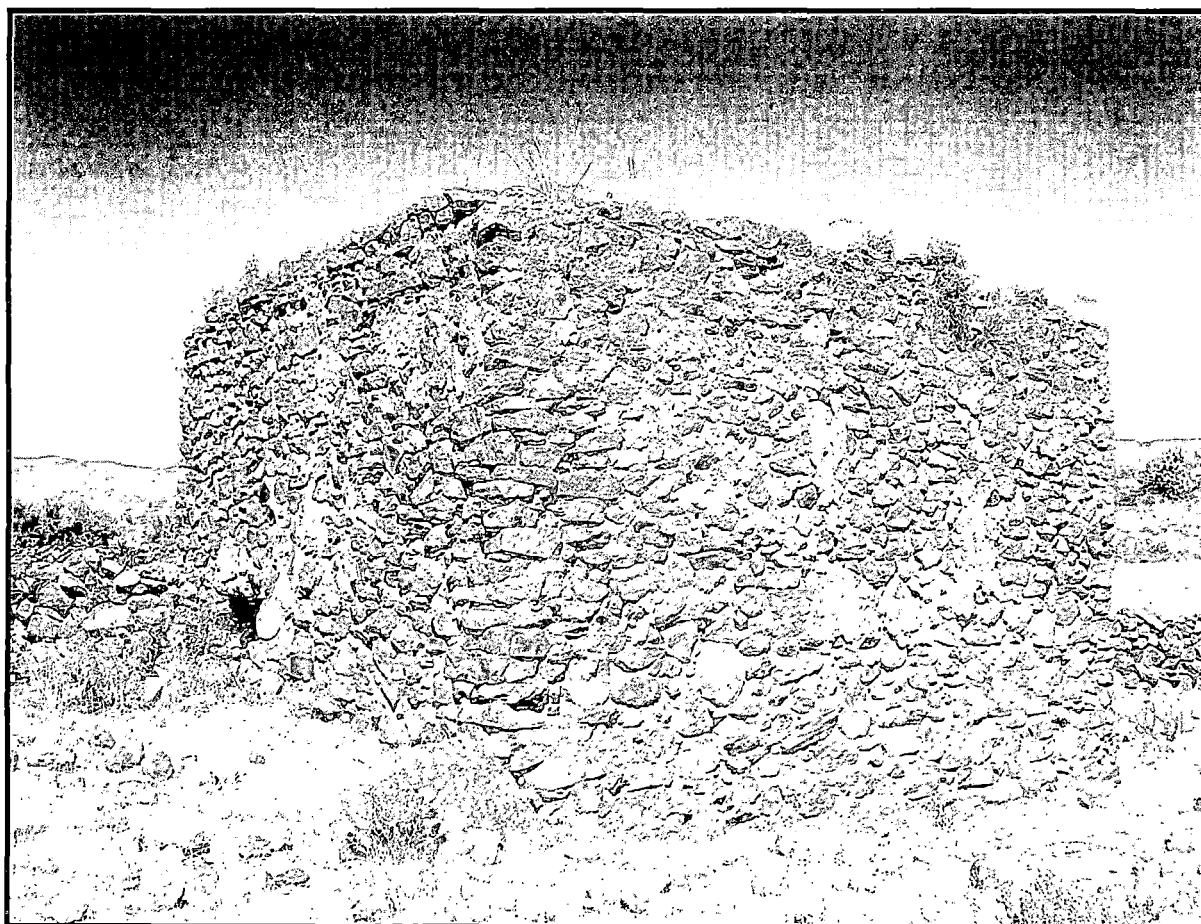
Fig. 111b Estructura arquitectónica de forma rectangular
