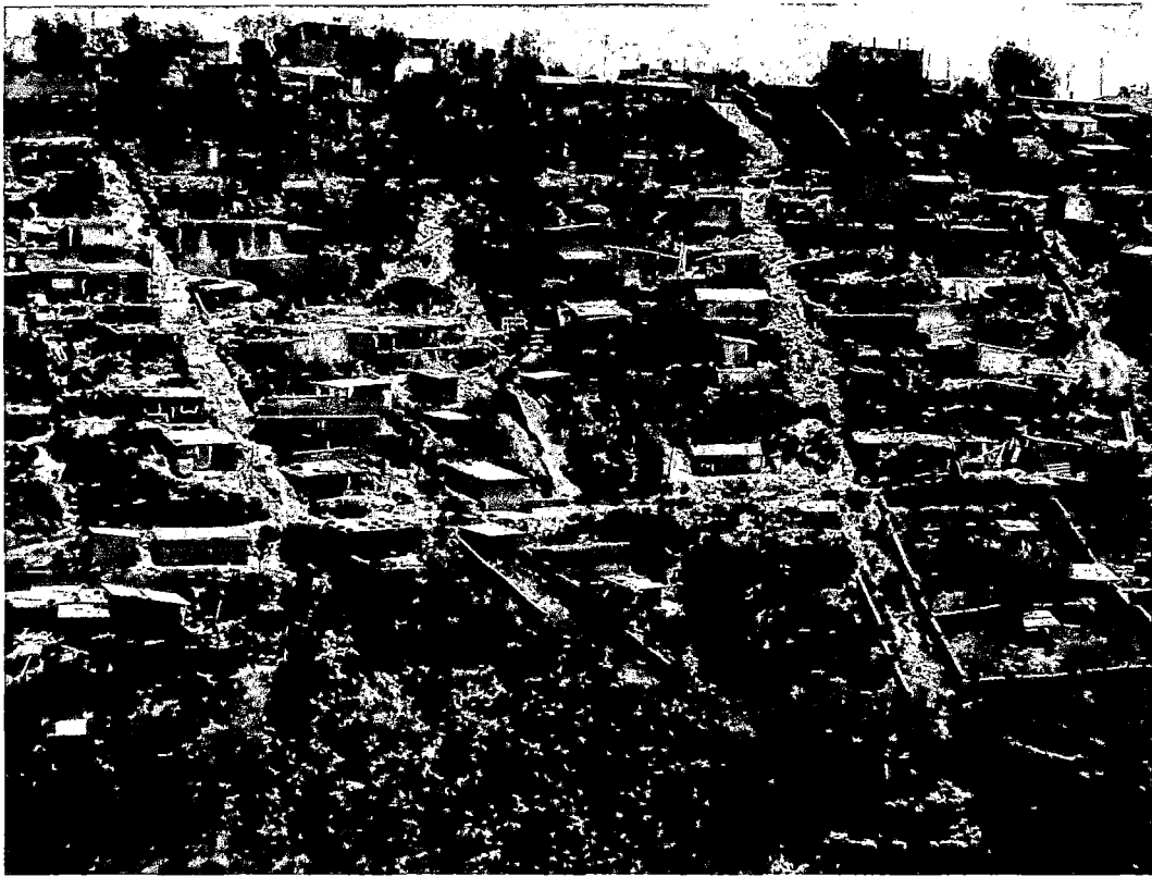
Fotografía N° 7. Zonas lotizadas con calles que conducen a barrancos. (Av. De la Muerte)
