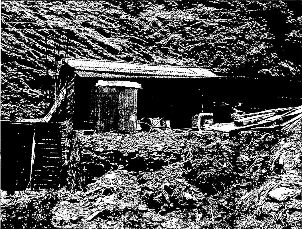
Fotografía N° 8. Viviendas lotizadas en rellenos y residuos sólidos.
