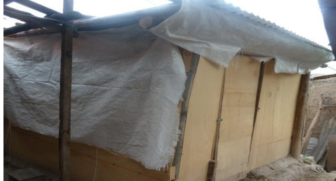
Foto 01 instalación y desinfección del galpón
