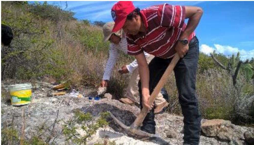
**Figura 2.3. Excavación para Monumentación del Punto Geodésico**
