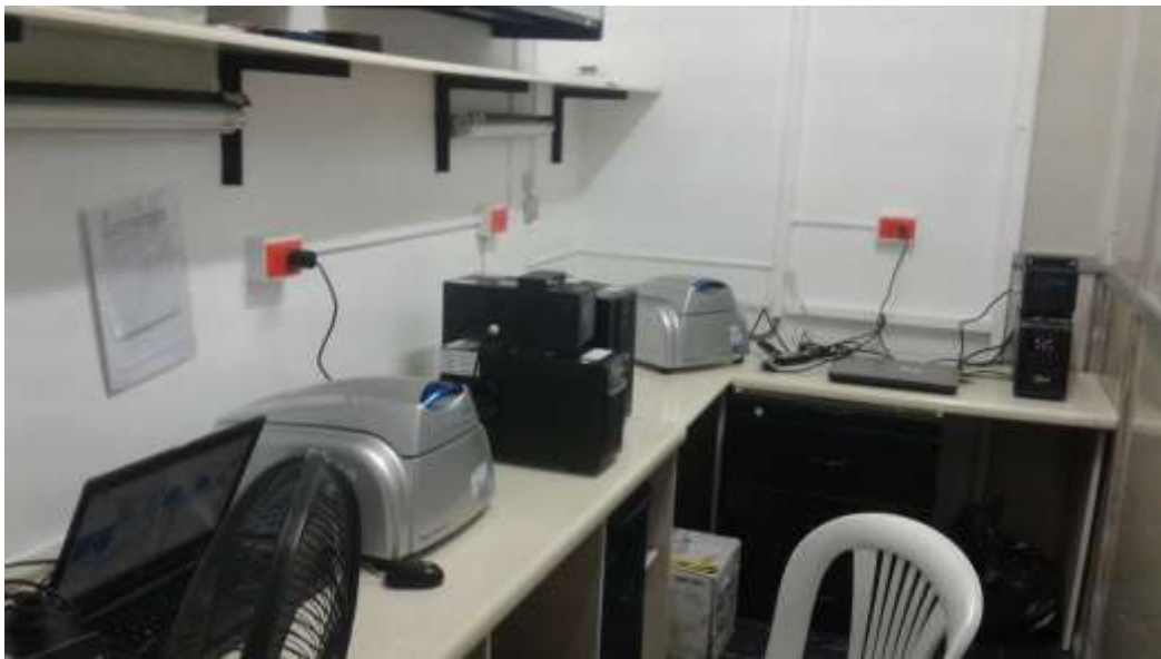
Figura 25. Cuarto de equipos de termocicladores del Instituto Nacional de Salud.
