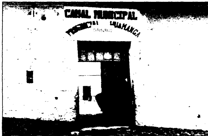
Foto 2.1: Fachada del Ex -Camal Municipal.
