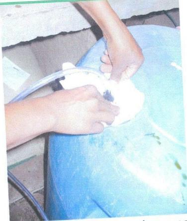
**Foto 11.** Se colocó 1.0 m de manguera transparente con diámetro 8 mm
