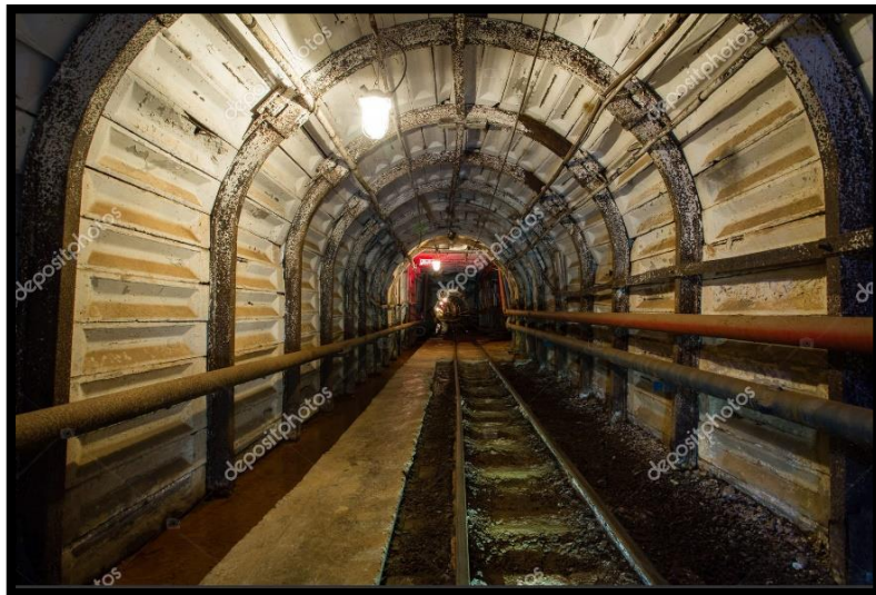
Figura 8: Instalación Línea Trolley y Cauville para transporte mediante locomotoras.
