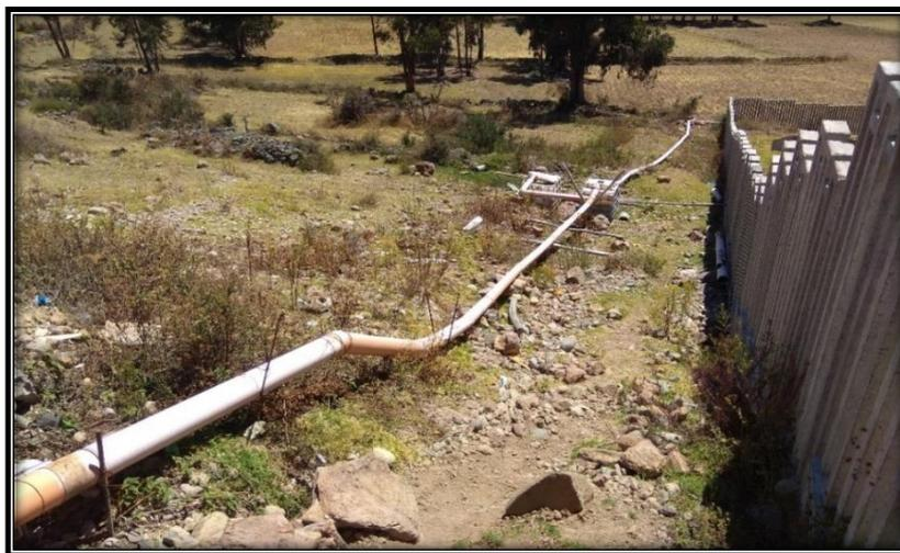
*Figura 3: Baipás de tubería de agua no tratada Cabrapata que alimenta a Huascaura y Mollepata y anexos.*
