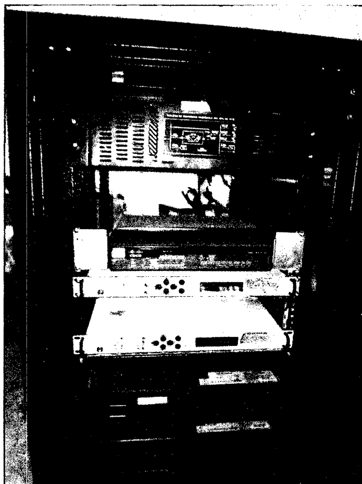
Figura N° 4.17: Gabinete de centro de datos de la red WAN Ayna - Kimbiri Fuente: Elaboración Propia
