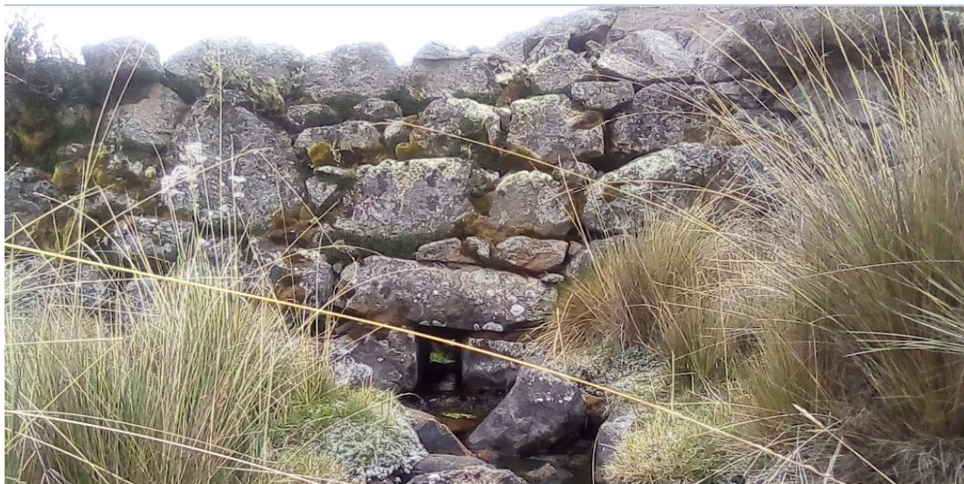
Figura 4.19. Muro de la presa prehispánica en Pamparomás
