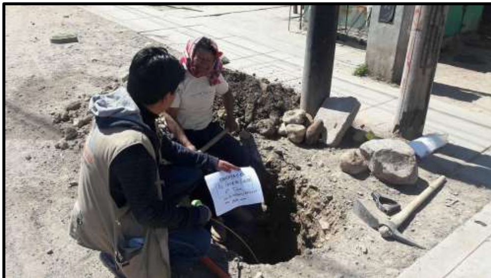
VISTA FOTOGRAFICA DE LA CALICATA C-C2, UBICADA EN LA SEXTA CDRA. DE LA URBANIZACION ENACE
