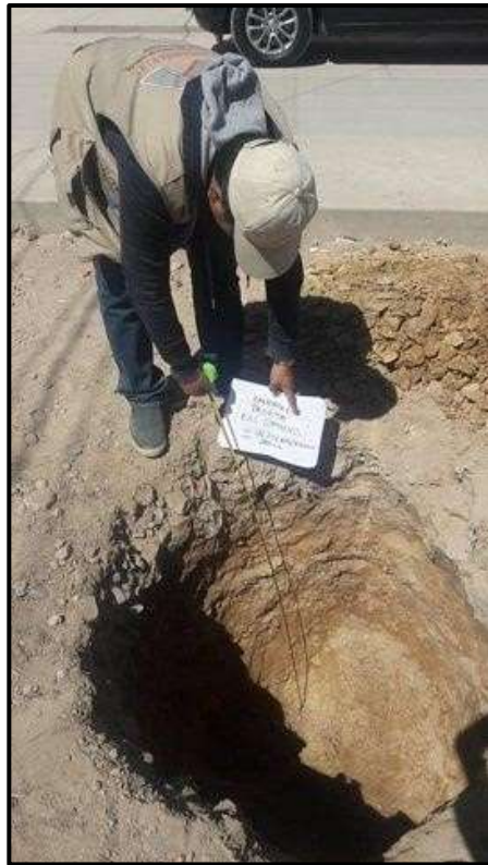
VISTA FOTOGRAFICA DE LA CALICATA C-C4, UBICADA EN EL PASAJE LAS RETAMAS DE LA URBANIZACION ENACE
