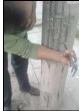
Medida de área afectada, profundidad, y espesor de armadura.
