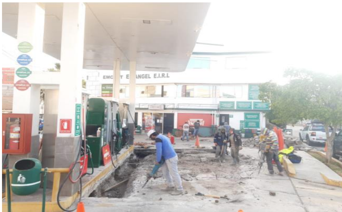
FOTO 1. Mantenimiento de tuberías por detección de fugas
