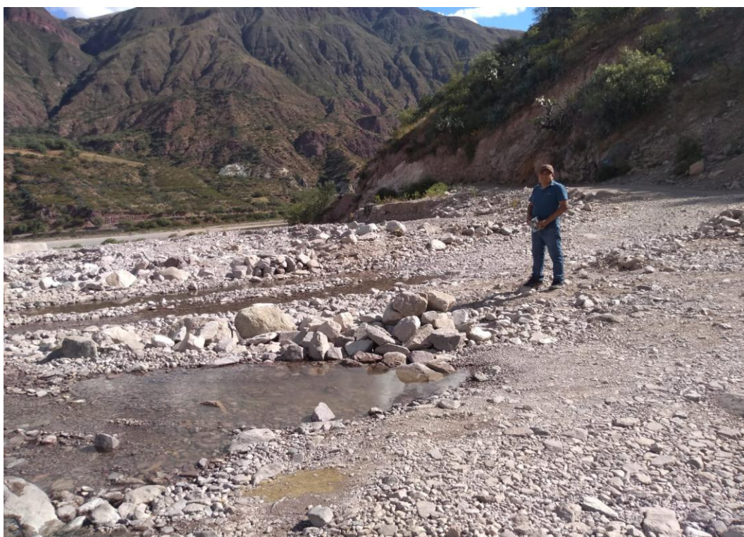
Fotografía 2. Vía de acceso que cruza el cauce del río se observa la falta de estructura vial para el cruce de vehículos y personas
