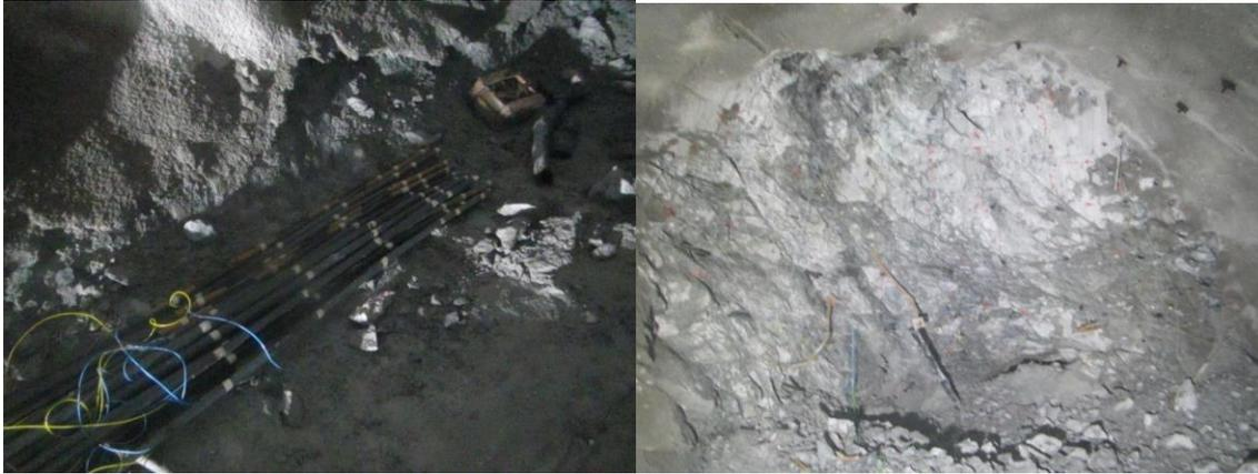
En la figura 22 se observa el frente cargado de acuerdo al diseño planteado.
