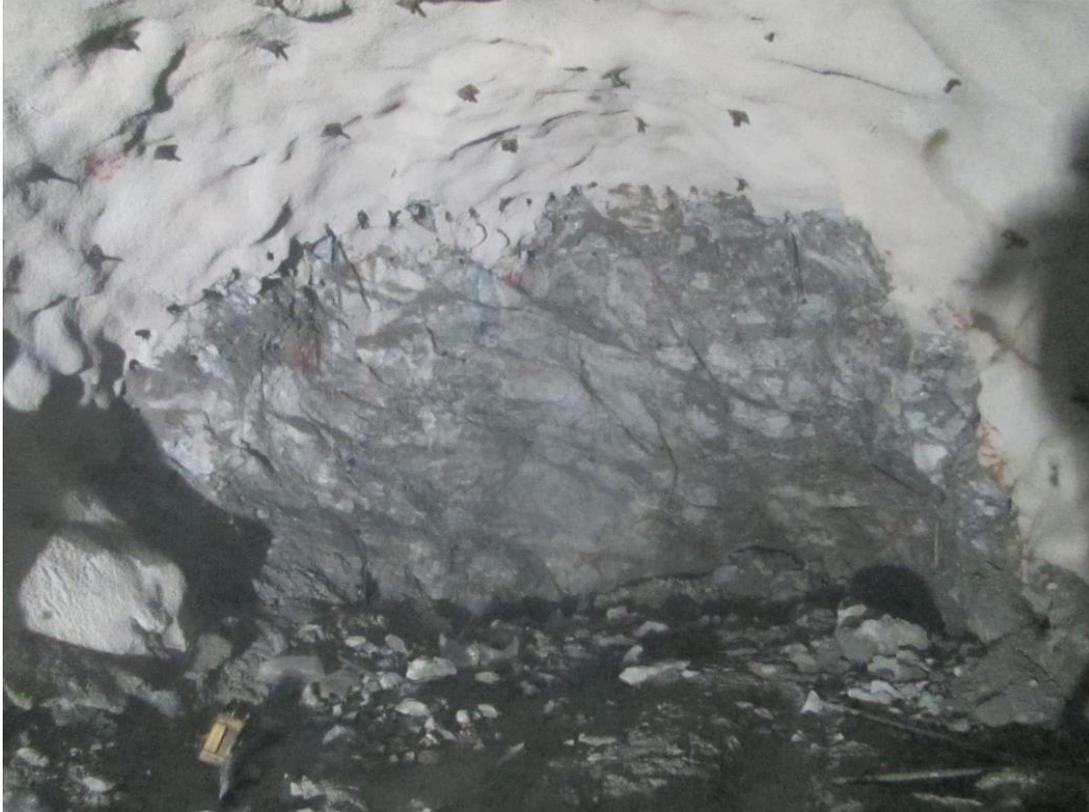
**Figura 15:** Evidencias de labor estable TJ1995, de acuerdo al diseño en sección de 8x5 hasta los 10x6m
