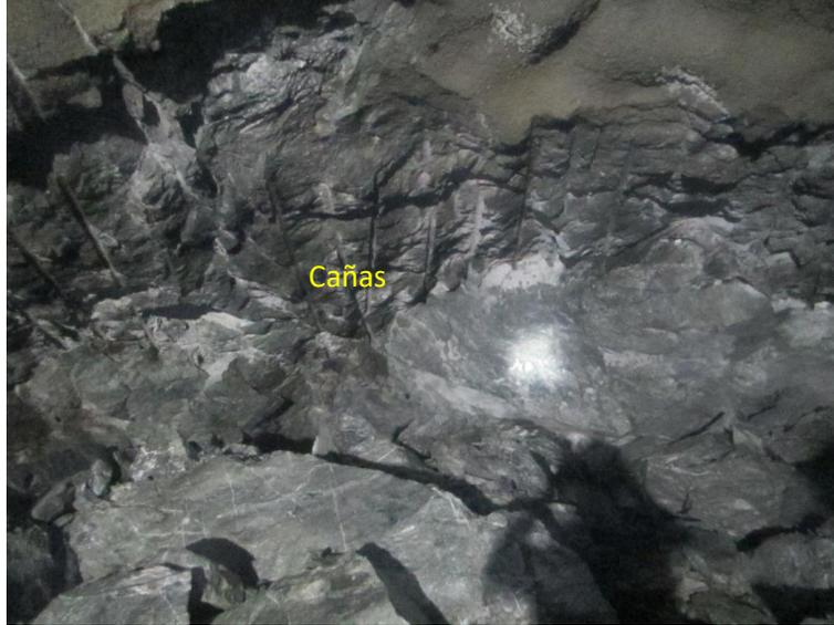
En la figura 26 se observan las cañas, indicador de que la corona no ha sido dañado por vibraciones generados por voladura.
