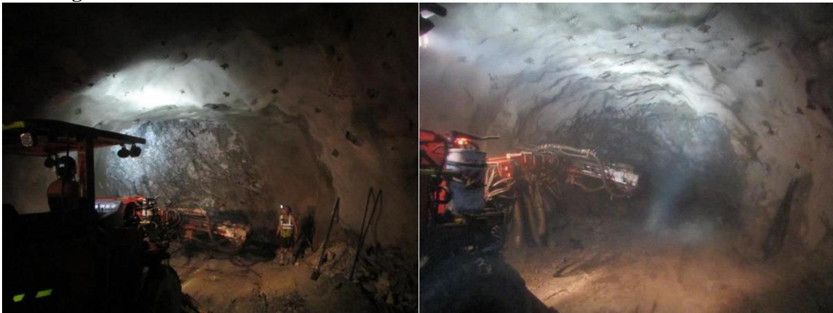
En la figura 21 se observa el proceso de instalación de pernos swellex de 7pies.
