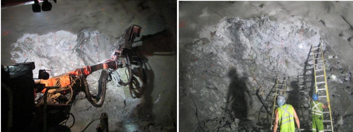
En la figura 20 se observa la correcta perforación del frente con equipo jumbo Sandvik DD311 con barra de 12ft.
