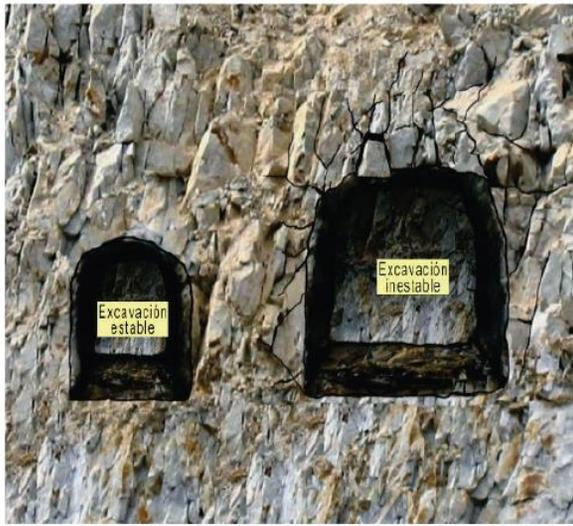
Cuando las dimensiones de la excavación crecen, aumenta la posibilidad de que la roca pueda deslizarse o caerse
