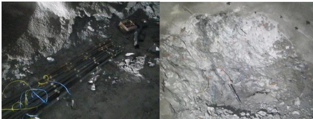
En la figura 75 se observa el frente cargado de acuerdo al diseño planteado.
