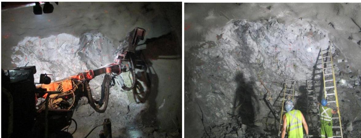
En la figura 73 se observa la correcta perforación del frente con equipo jumbo Sandvik DD311 con barra de 12ft.
