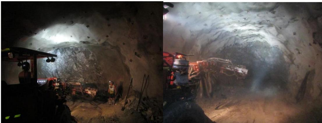
En la figura 74 se observa el proceso de instalación de pernos swellex de 7pies.
