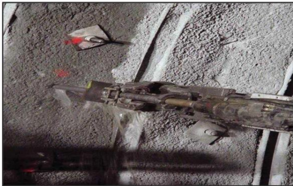
Pernos auto perforantes con relleno cementado
