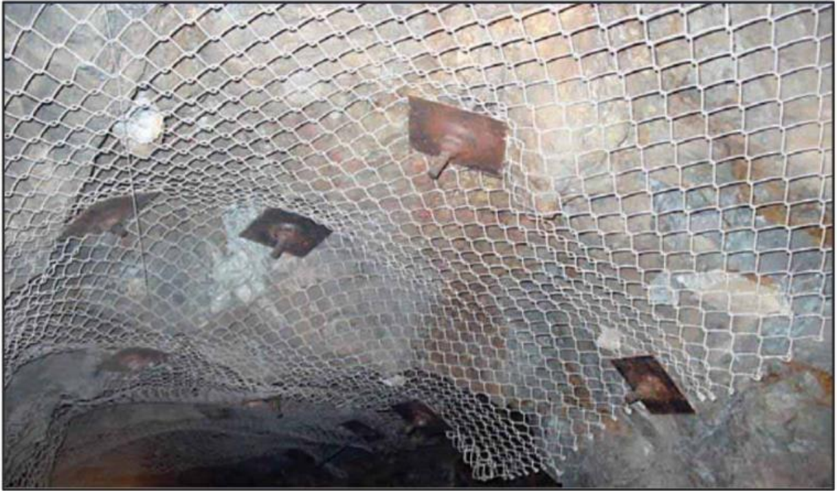
Pernos auto perforantes con relleno cementado
