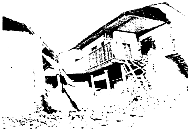
Angel Ramón (fotografo). 2016. “Quedó el inmueble destruido.” (fotografía). Diario Correo de Huancayo, Pared de casona se desploma y aplasta a un cibernauta . Huancayo, 16 de abril del 2016.
