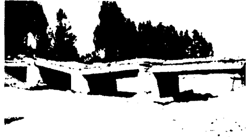
“Puente de Masma-Chiche colapsa por desborde de río.”
