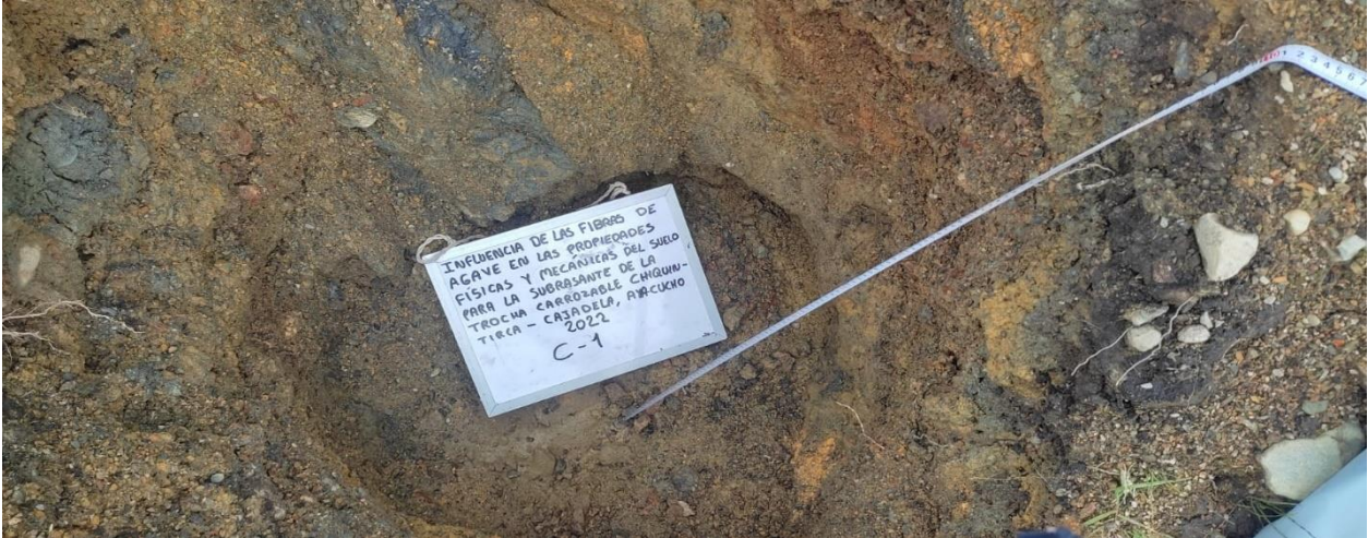
Figura 8: Reconocimiento de la calicata de estudio
