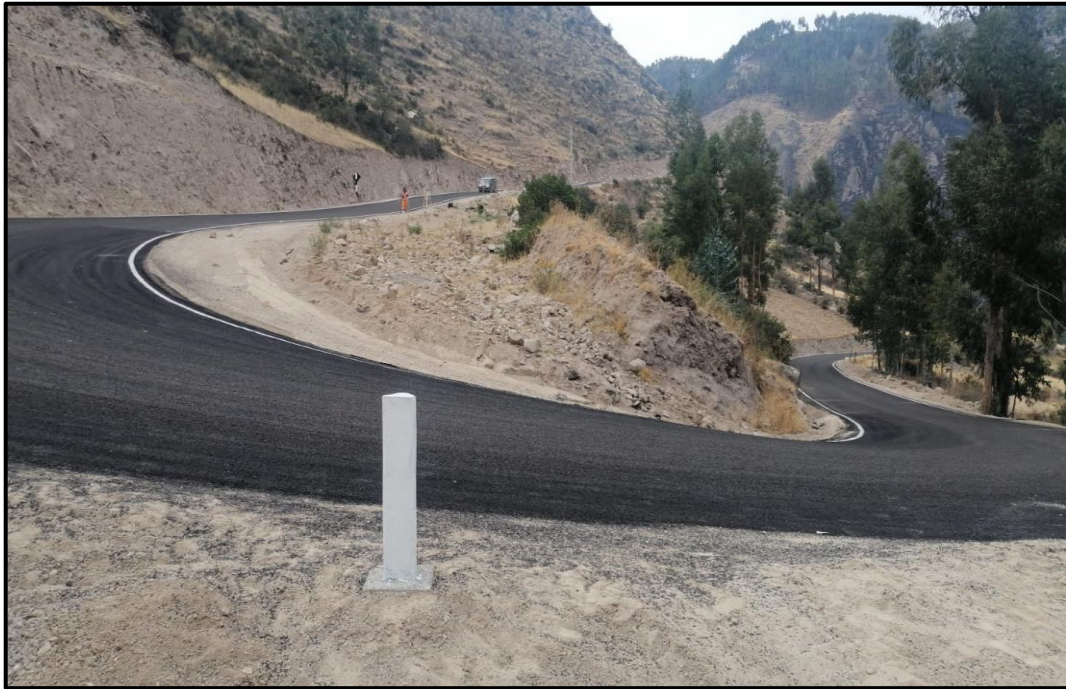
Anexo 1.3. Curva con sobreancho y berma 0.50m
