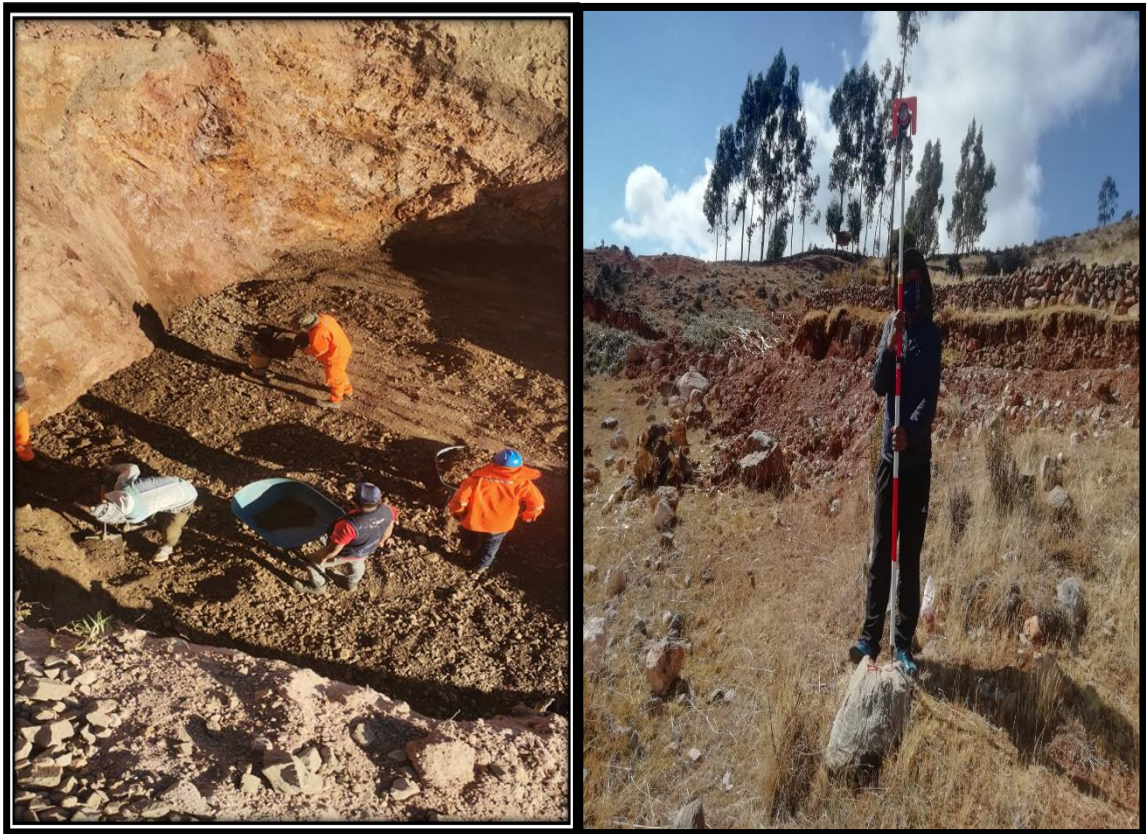
Figura 11 Trazo y replanteo de la carretera
