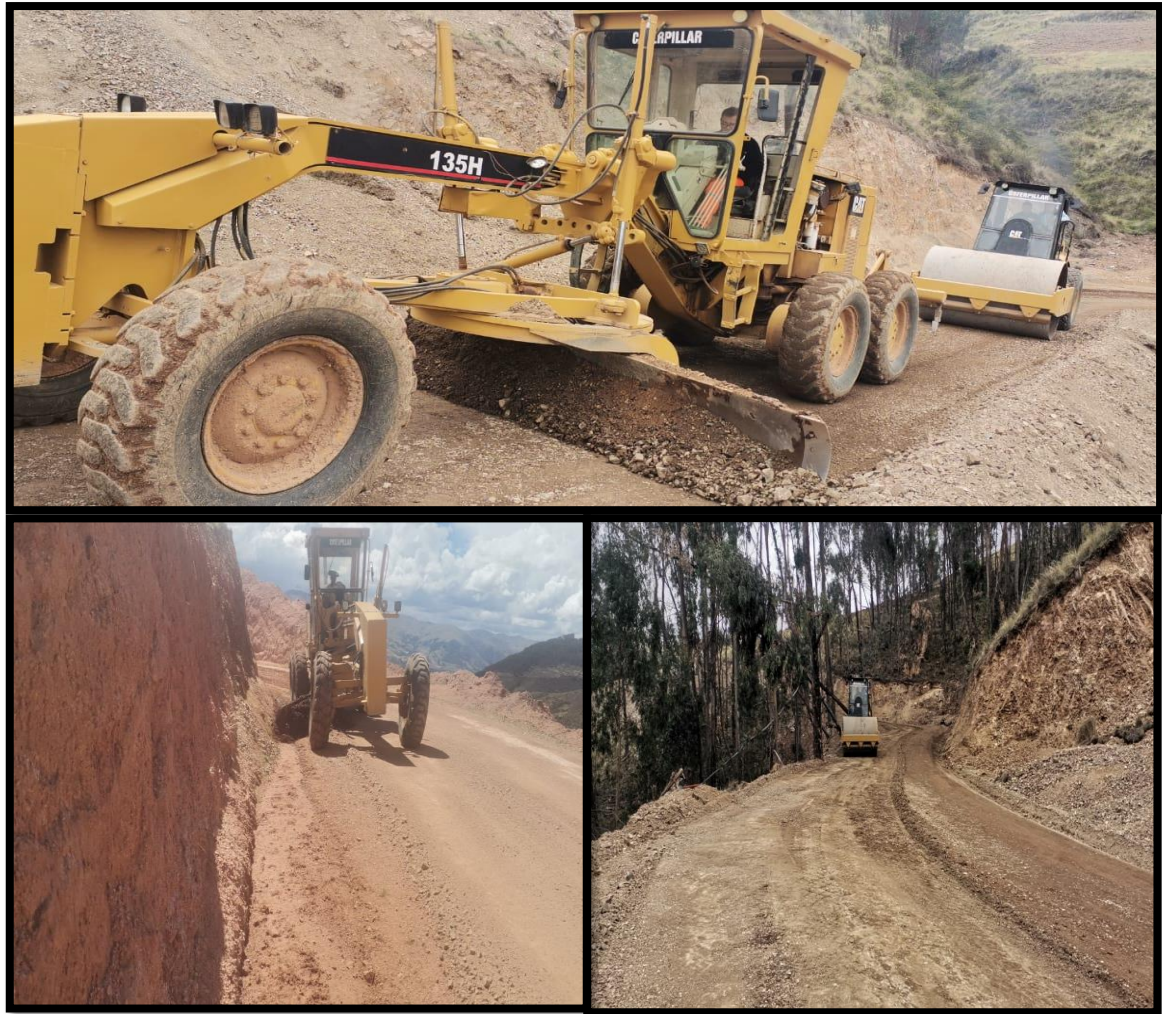
Figura 11 Trabajo de conformación de terraplenes
