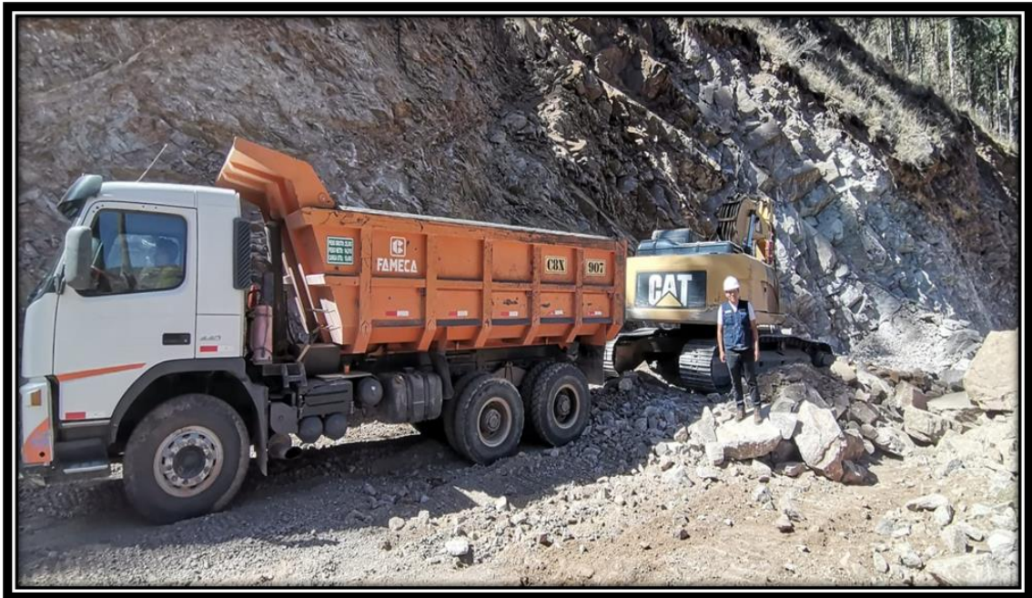
Figura 19 Perfilado de la carretera
