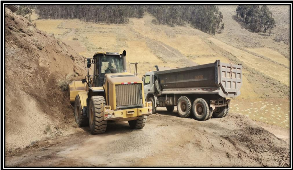
Figura 13 Relleno compactado de la carretera
