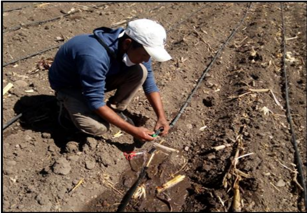
Foto 11. Reparación de cintas con uniones.
