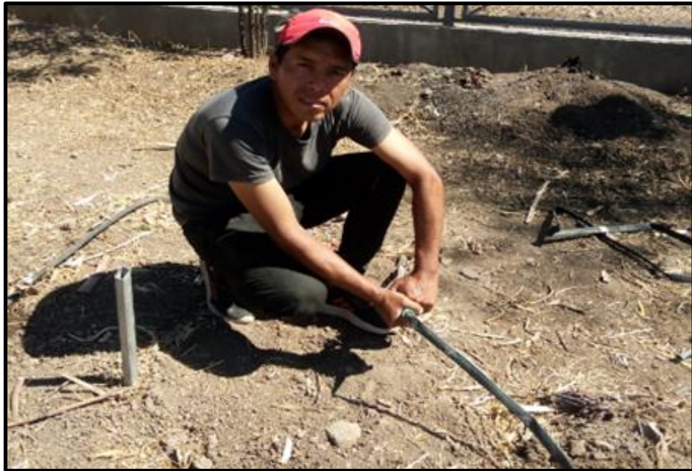
Foto 9. Instalación de cintas de riego por goteo.
