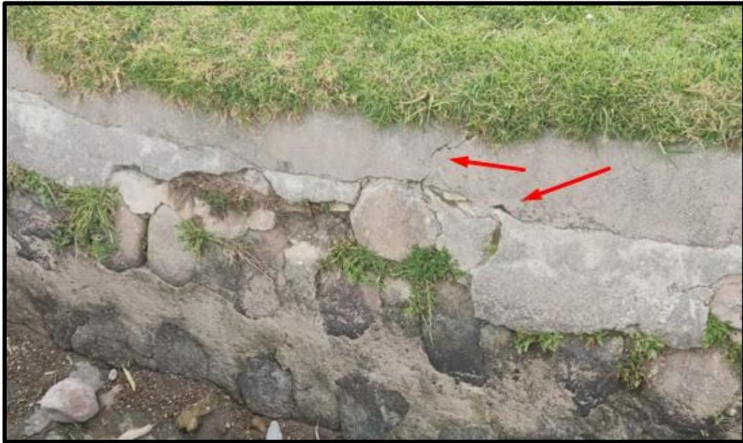
Posibles causas: Se produce el agrietamiento por el empuje de tierras. Por contracción, debido a las altas o bajas temperaturas. Por la ausencia de juntas de dilatación en las zonas requeridas.
