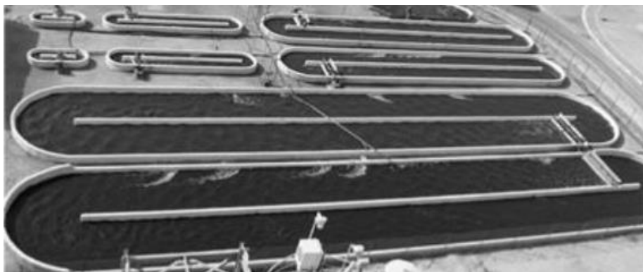
Estanques tipo raceway
