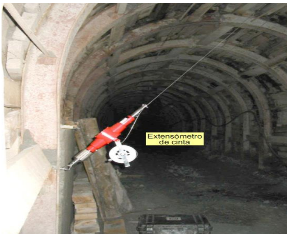
FOTO N° 2: Extensómetro de cinta para medir la convergencia
