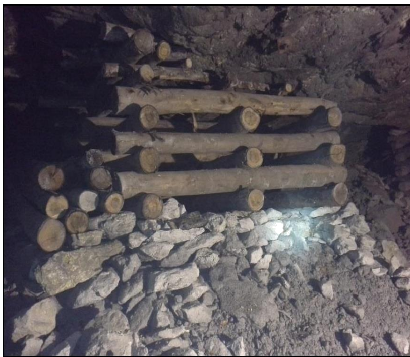
FOTO N° 16: Sostenimiento con Woodpack
