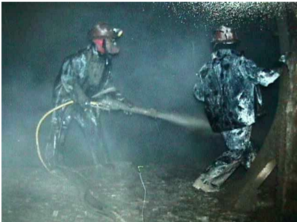
FOTO N° 11: Aplicación de Shotcrete
