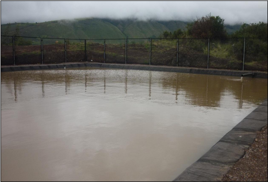
Fotografía 3. Reservorio de 500m 3 de sistema de riego San Juan de Rayan.
