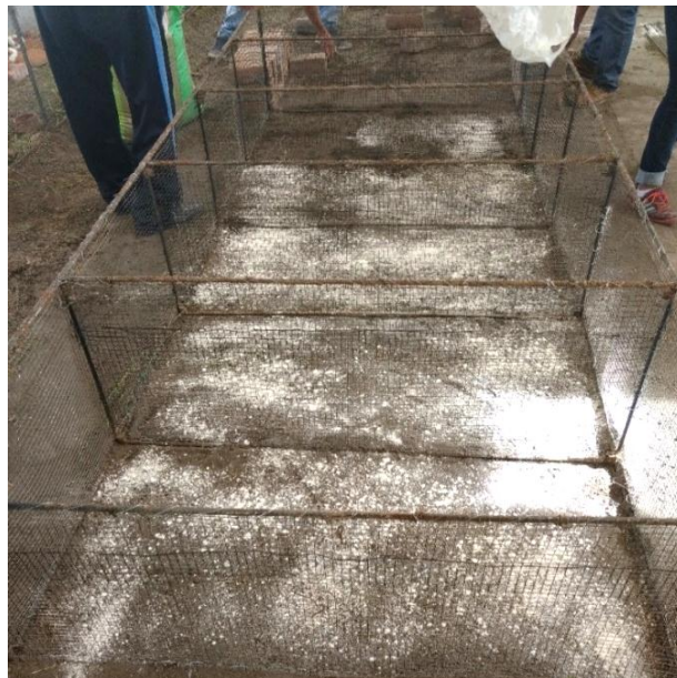
Figura 2.2. Posas construidas con fierro corrugado y malla galvanizado
