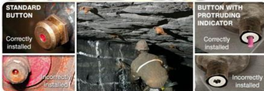
Figura 3. Botón de indicador e incorrecta instalación.
