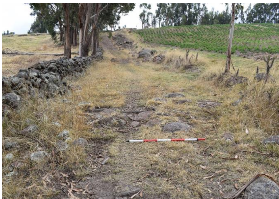
Fig. 58: Vista de la calzada con amojonamiento en los laterales del camino del segmento bajada dirigida hacia la quebrada de Qosqohuayqo, Progresiva 58+960 km.
