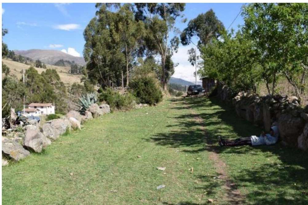
Fig. 89: Vista de una calzada con presencia de un muro de protección lateral izquierdo segmento ubicado en la localidad de Paqcha, Sección 2, Pomacocha – Pte. Huaraco, UTM: E: 606296.894, N: 8499143.804, Progresiva 14+980 km.
