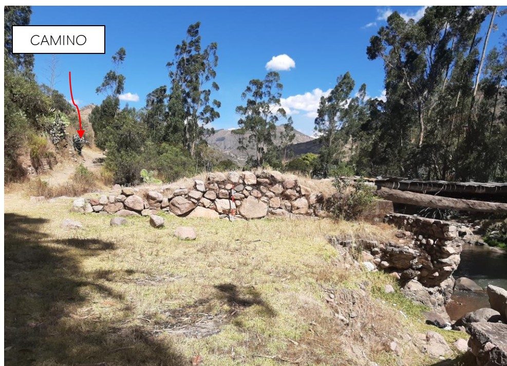
Fig. 15: Vista del paramento de la construcción del estribo del puente Pomacocha, construcción que permite la elevación de la calzada con la finalidad de impedir el tope con la corriente del río Vischongo, UTM: E: 610105.194, N: 8494036.264, Progresiva 6+180 km.
