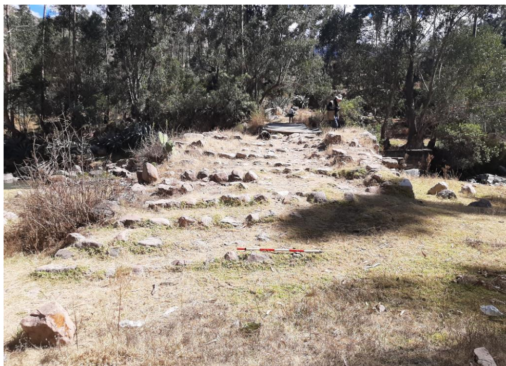
Fig. 16: Vista de la construcción del estribo con escalinatas del puente Pomacocha, UTM: E: 610105.194, N: 8494036.264, Progresiva 6+180 km.
