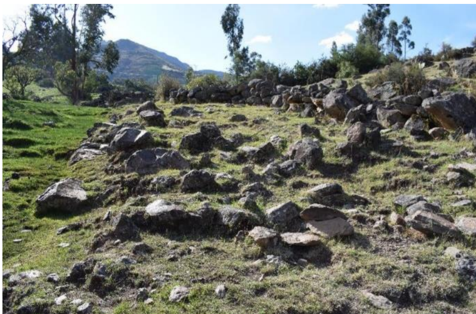
Fig. 81: Detalle del empedrado en un área con presencia de bofedal, sección Pte. Huaraco – Quishuarcancha, UTM: E: 607882.044, N: 8494807.014, Progresiva 8+940 km.
