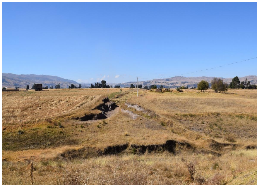
Fig. 37: Vista panorámica de uno de los segmentos del camino principal ubicada en la llanura de Huanuhuanu perteneciente a la sección 3, Progresiva 32+040 km.
