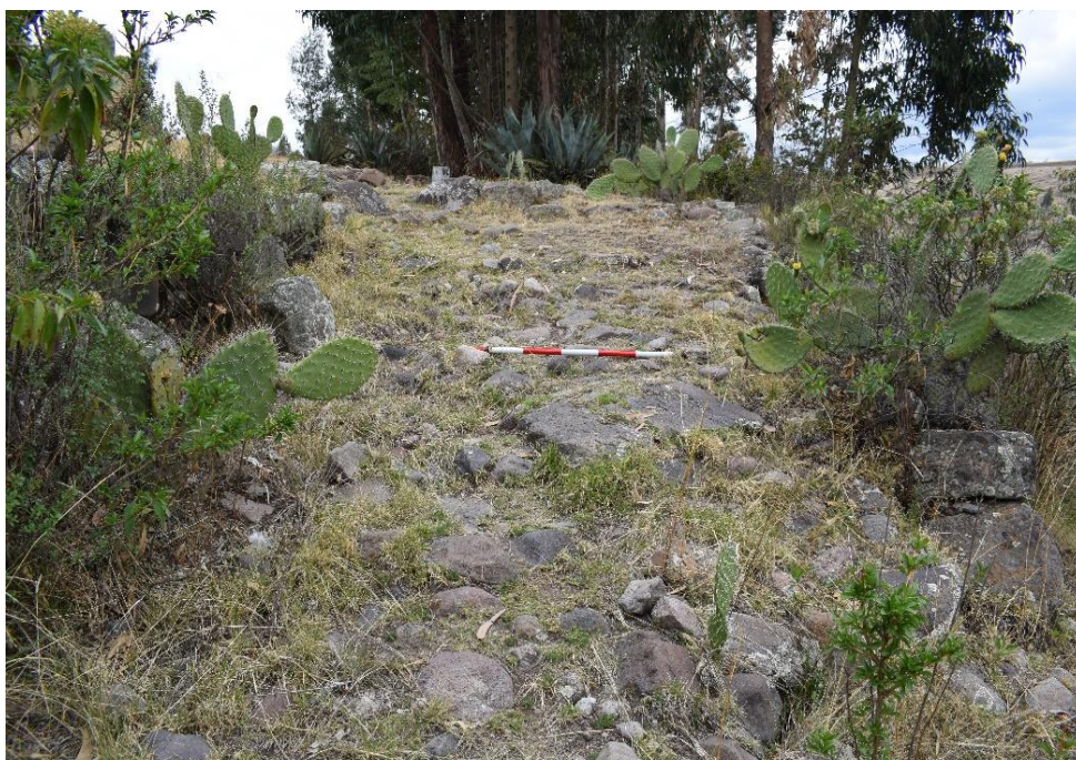
Fig. 60: Vista de la calzada empedrada con muros de contención en el lateral derecho del camino ubicada en el margen izquierdo del río Lambrashuayqo, Progresivas 66+300 km - 66+440 km.
