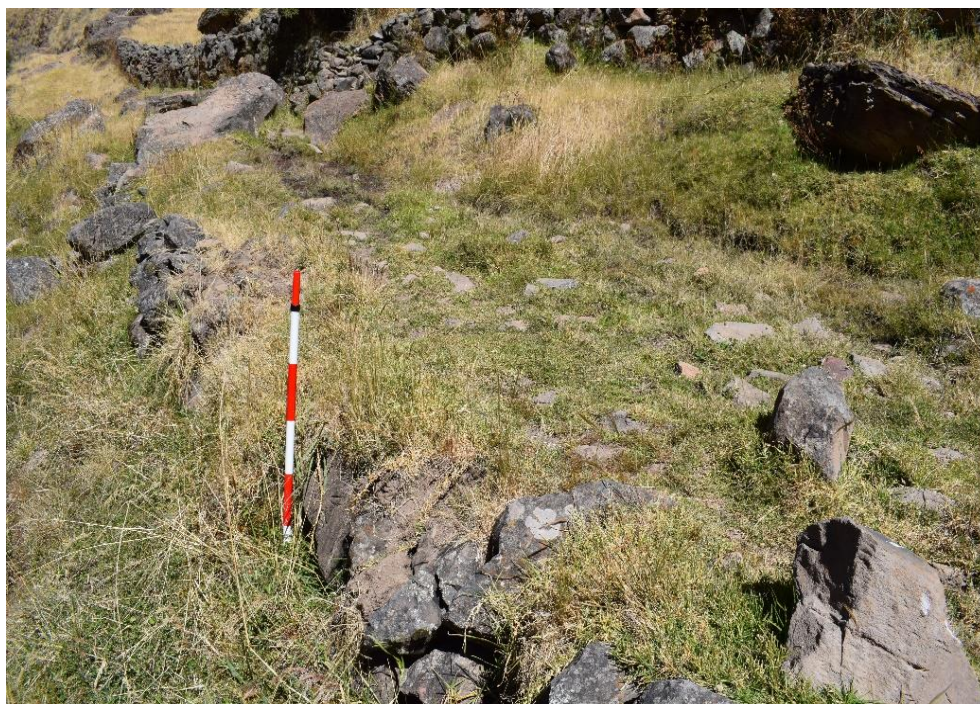
Fig. 32: Vista en detalle de la calzada empedrada con muros de contención perimetrales en segmentos con presencia de bofedales, Prog. 17+980 km.
