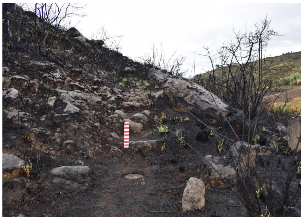
Fig. 55: Vista en detalle de la escalinata empedrada ubicada en el segmento de la quebrada de Molinohuayqo, sector 5, Progresiva 50+080 km.
