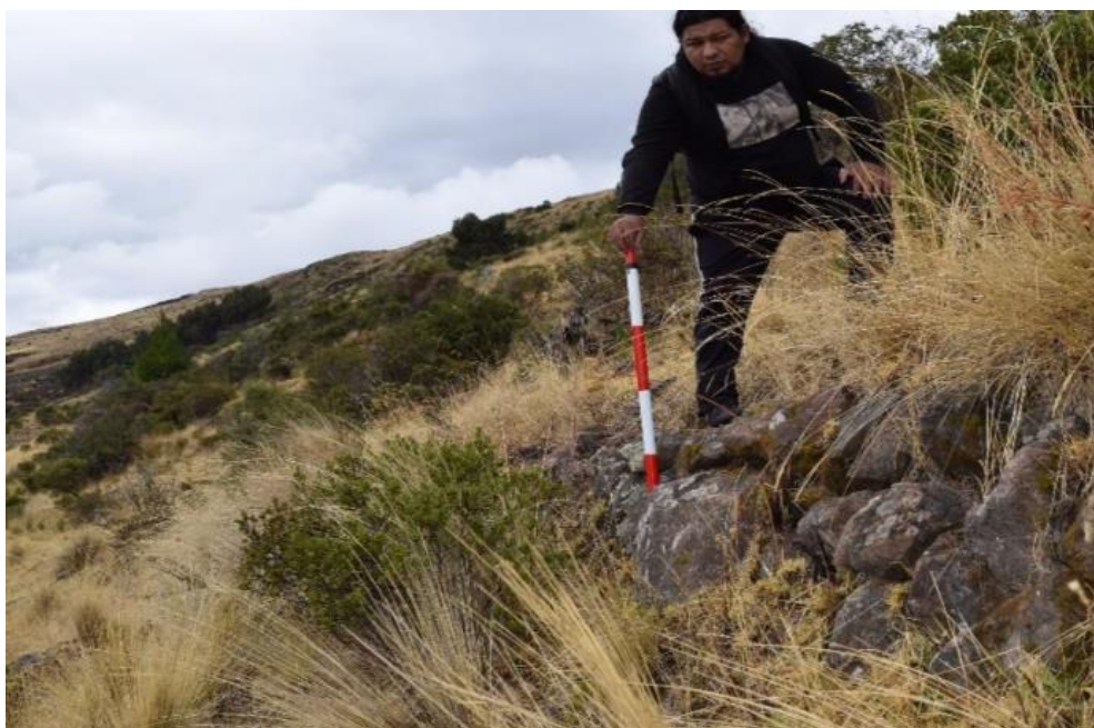
Fig. 87: Vista de un muro de contención en la calzada del segmento del camino ubicada en el sector izquierdo de la quebrada de Molinohuayqo, Sección 5, Toccto – Huamanga, UTM: E: 585820.989, N: 8528364.413, Progresiva 56+720 km.
