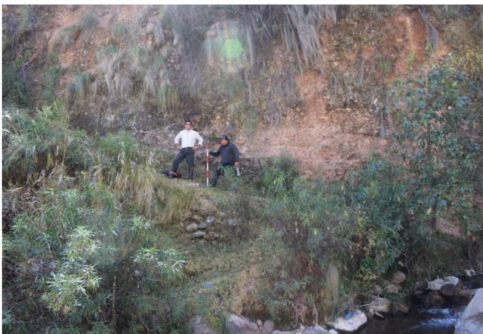
Fig. 72: Detalle del muro de contención en un área abrupta, sección Vilcashuamán – Pomacocha, UTM: E: 610696.561, N: 8493257.982, Progresiva 4+800 km.
