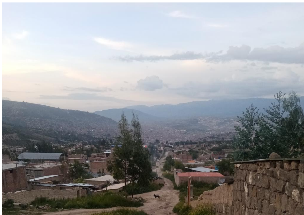
Fig. 64: Vista panorámica de la calle actual del Jr. Cangallo, uno de los segmentos del camino principal ubicada en el ingreso a la ciudad de Huamanga, progresiva 71+080 km.
