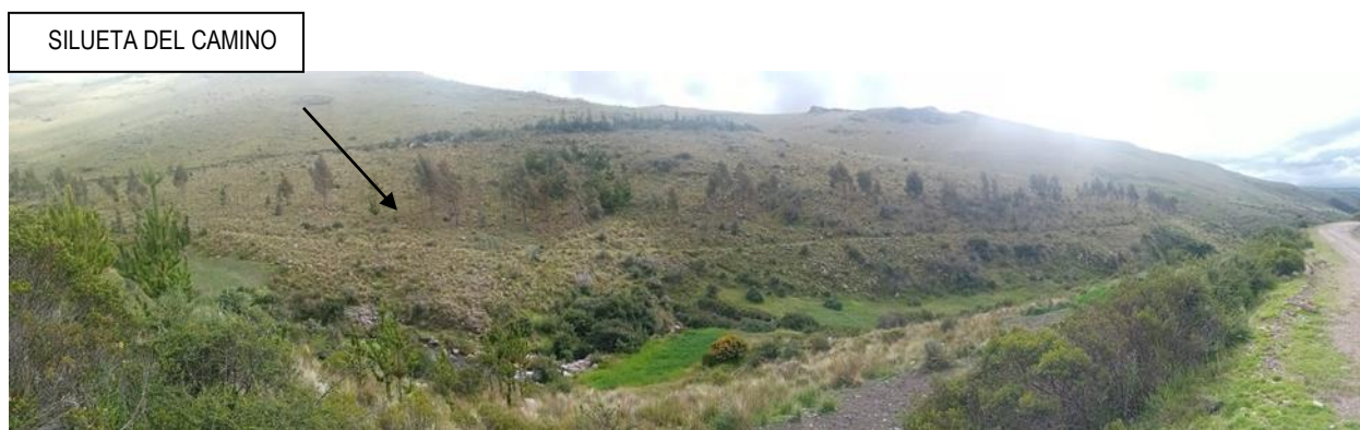
Fig. 54: Vista panorámica de la silueta del camino que desciende la quebrada de Molinohuayqo, uno de los segmentos del camino principal del sub tramo Vilcashuaman – Huamanga, ubicada en el sector 5, Progresivas 54+340 km – 54+900 km.
