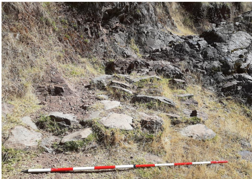
Fig. 32: Vista en detalle de la calzada empedrada con muros de contención perimetrales en segmentos con presencia de bofedales, Prog. 17+980 km.
