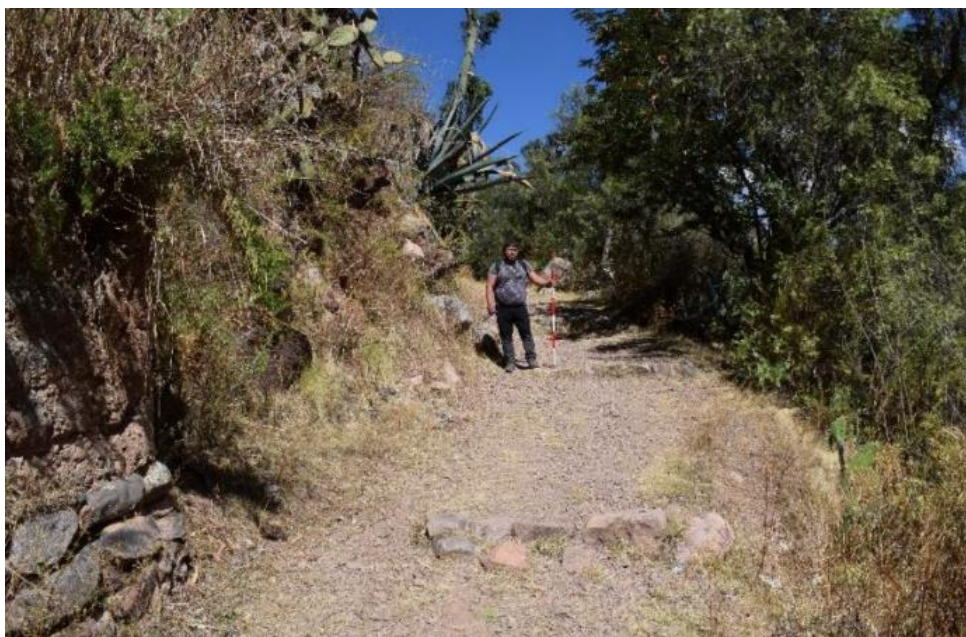
Fig. 80: Vista en detalle de la calzada con presencia de empedramiento en forma escalonada ubicada en Ergomarca, Sección 1, Vilcashuamán – Pomacocha, UTM: E: 610132.532, N: 8493970.468, Progresiva 6+100 km.
