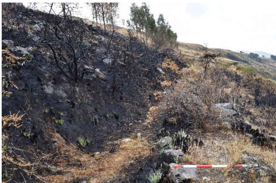
Fig. 90: Vista de la presencia de un muro de protección, detalle del segmento que se ubica en el sector izquierdo de la quebrada de Molinohuayqo, sección 5, Toccto - Huamanga, UTM: E: 586668.282, N: 8526757.814, Progresiva 54+760 km.
