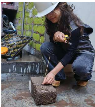
Figura 45 Medir la oquedad que deja el ensayo en el adobe.
