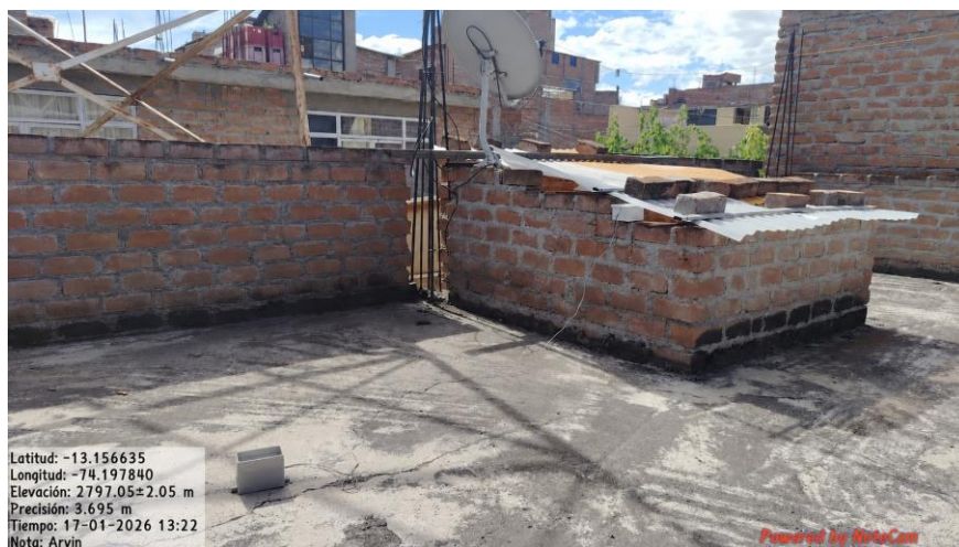
Fotografía 23. Instalación de estación de monitoreo Arvin.
