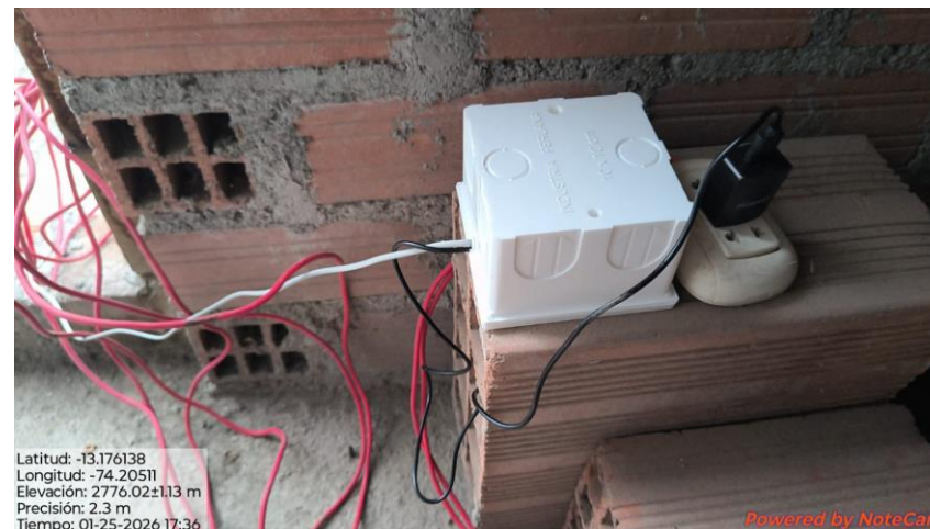
Fotografía 22. Acondicionamiento del módulo de transmisión en la estación de monitoreo Alder.
