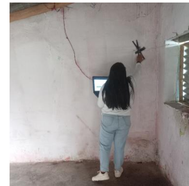
Fotografía 16. Instalación y verificación del equipo de monitoreo en punto de control interior.
