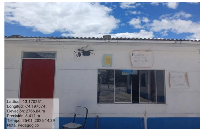
Fotografía 26. Instalación de estación de monitoreo en el Pedagógico.
