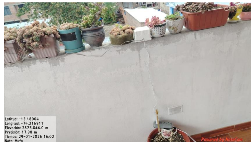
Fotografía 24. Instalación de pluviómetro y módulo de registro en estación de monitoreo Myfa.
