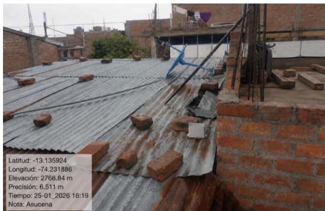
Fotografía 25. Instalación de estación de monitoreo Asucena.
