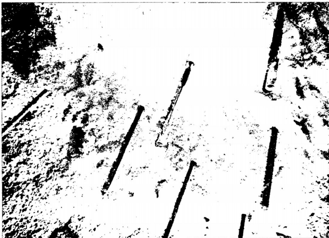
Fotografía N° 18: Entubado de taladros perforados.
