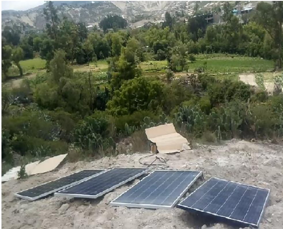
Foto 13: Instalación de los paneles fotovoltaicos
