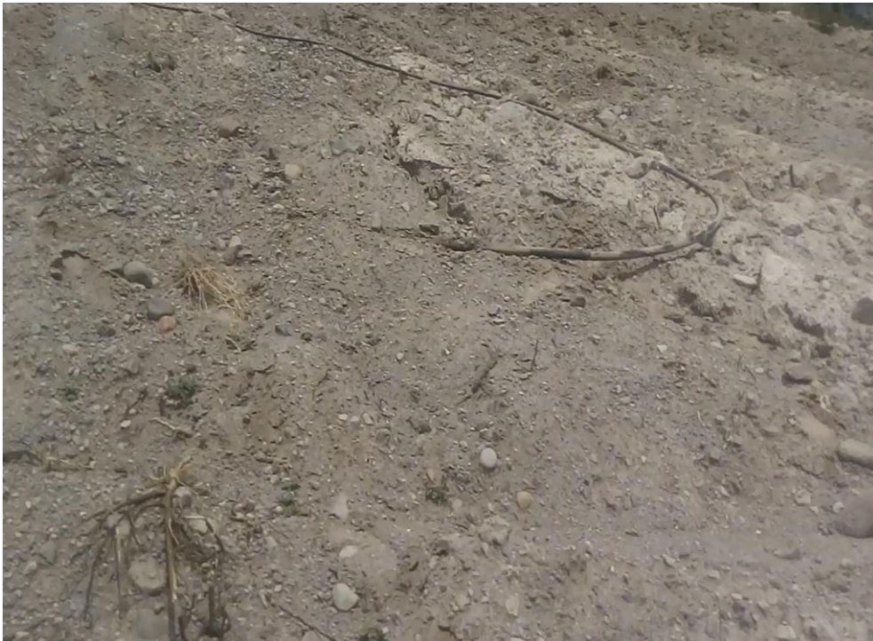
Foto 16: Instalación de la línea de conducción con manguera HDPE de 1´
