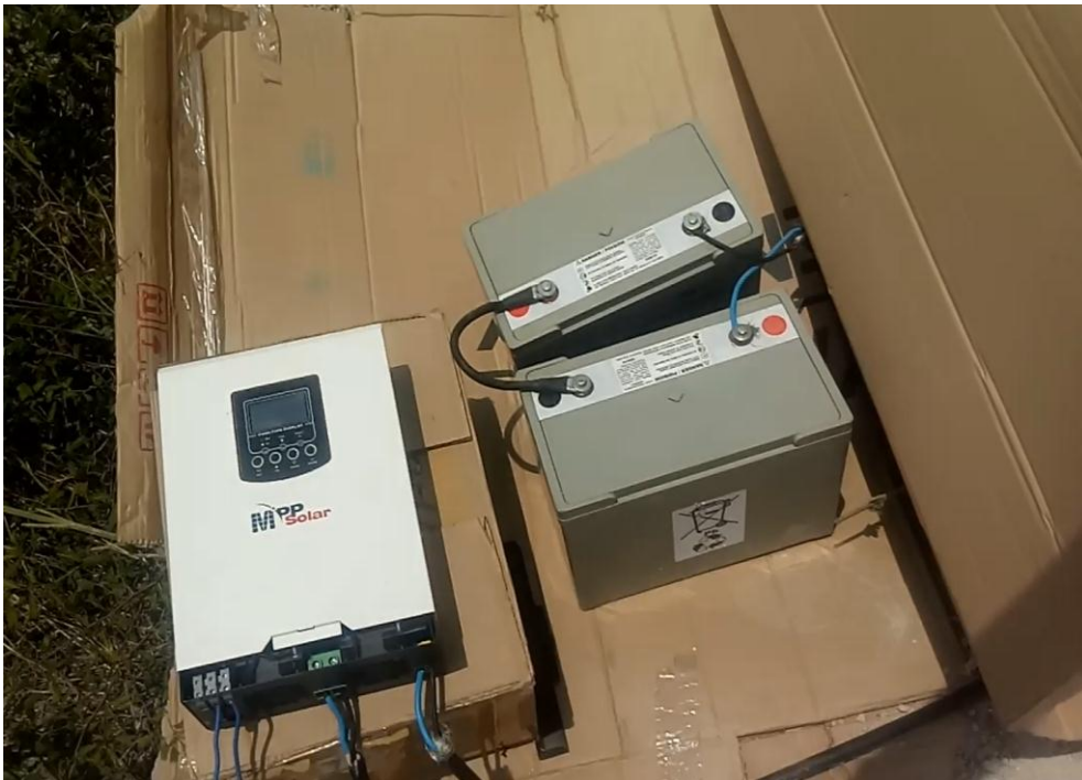
Foto 14: Instalación del inversor y la baterías solares
