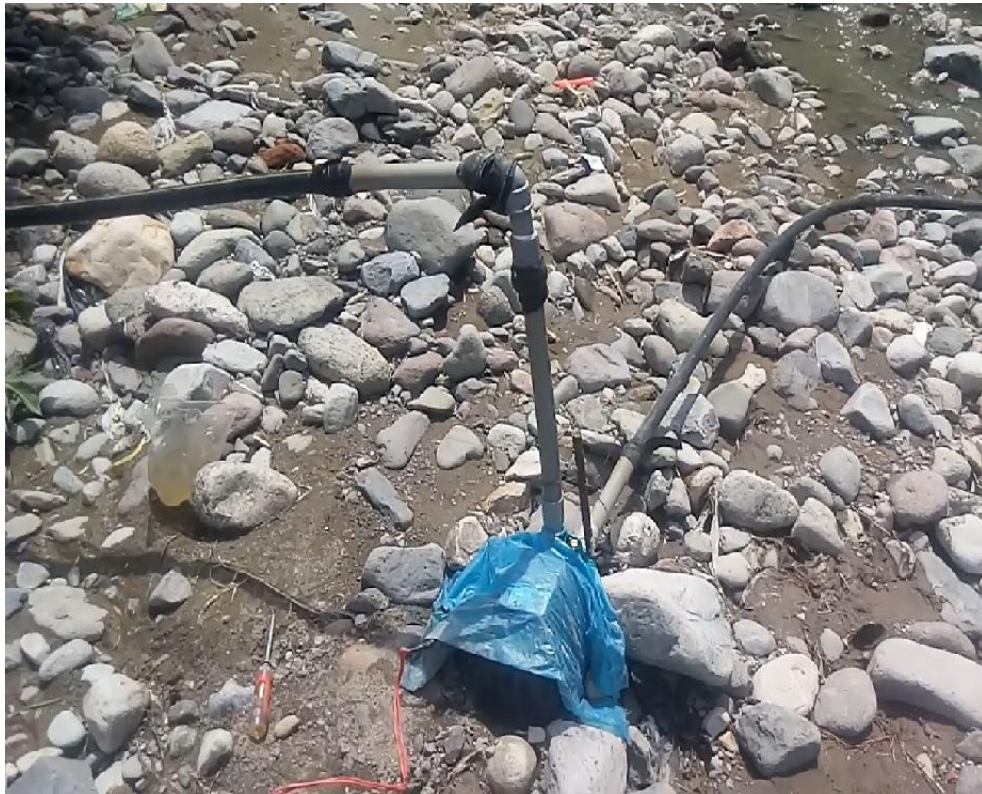
Foto 15: Instalación de una electrobomba
