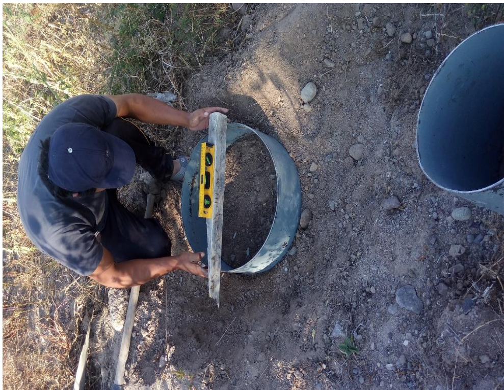
Foto 6: Prueba de infiltración
