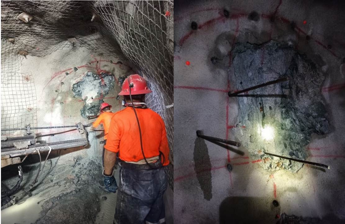
Figura 75. Trabajos de perforación del frente
