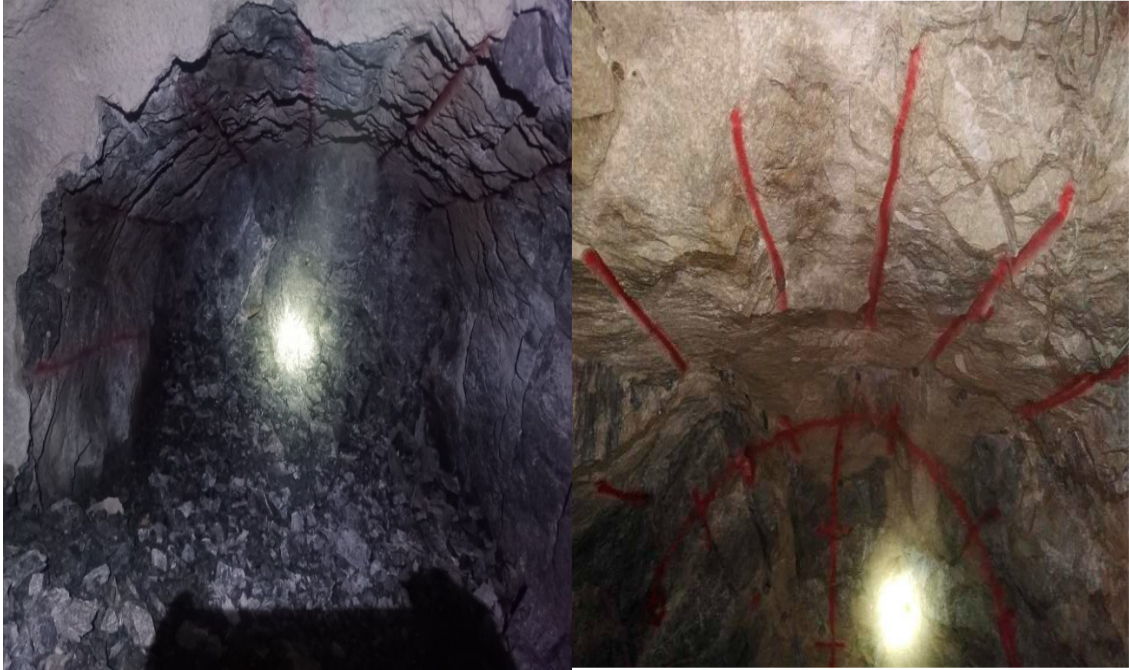
Figura 49. Media cañas visibles después de la voladura
