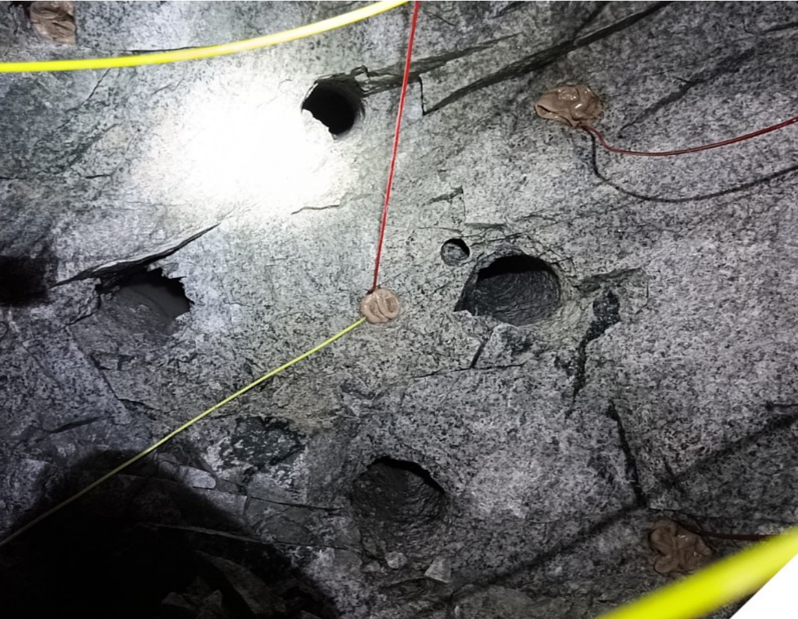
Figura 74. Taladros de arranque perforados
