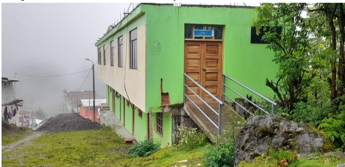
Figura 19. Casa del Maestro construido por Perú LNG
