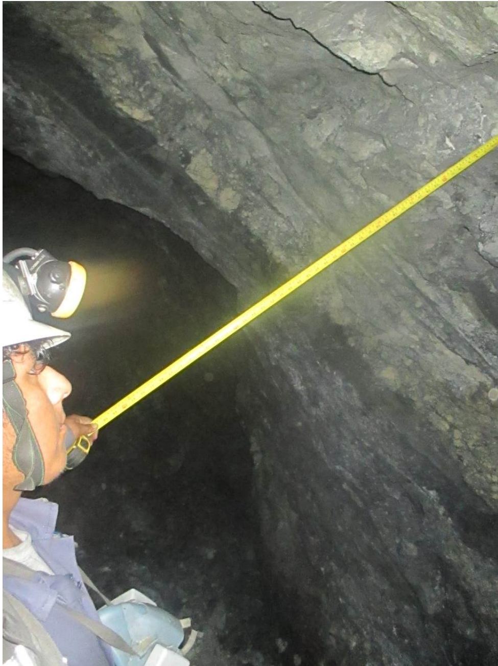
Foto 07 Control de longitud de perforación.
