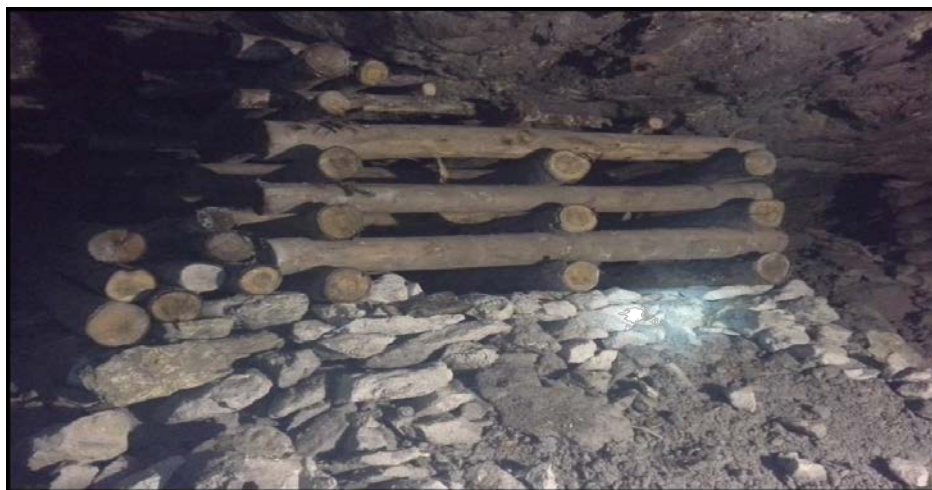
Foto: Sostenimiento con Woodpack
