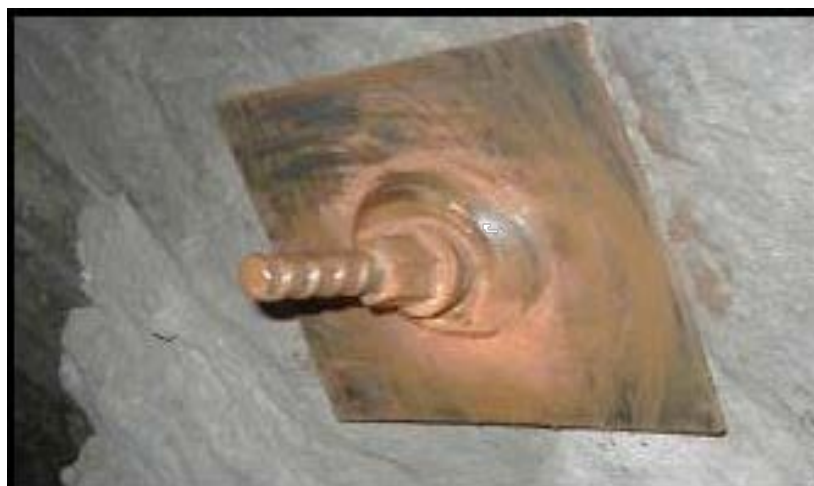
Foto: Sostenimiento con Perno Helicoidal
