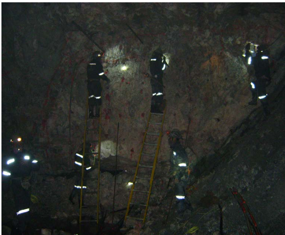
Foto 3: Carguio de taladros con explosivo en frente de tajeo.
