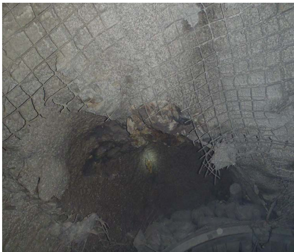
Foto 5: Malla metálica y shotcrete usado como sostenimiento.
