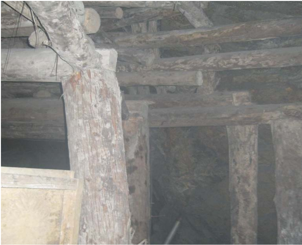
Foto 6: Sostenimiento con cuadros de madera.
