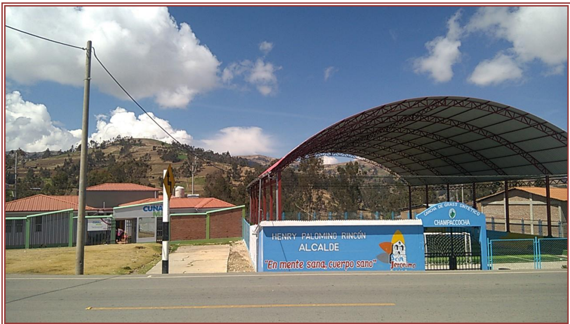
Vista Fotográfica 07: Vista panorámica del Centro Poblado de Champacocha
